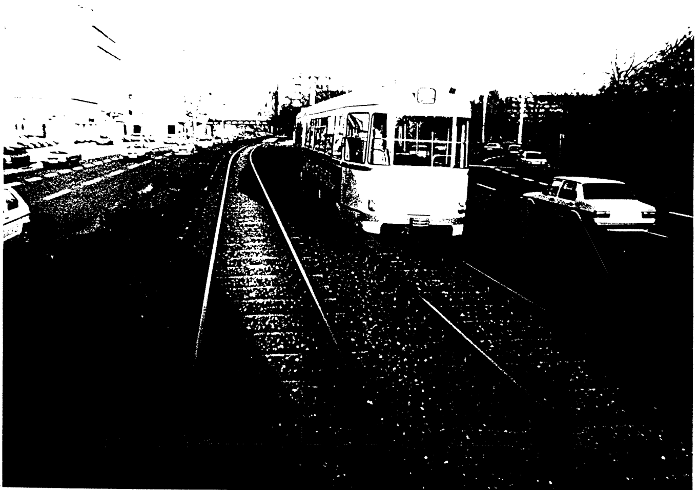
VOIES SUR BALLAST EN SITE SÉPARÉ PROTÉGÉ PAR DES HAIES SUR LA LIGNE 1 LE LONG DE L'AVENUE MACHENER STR.
