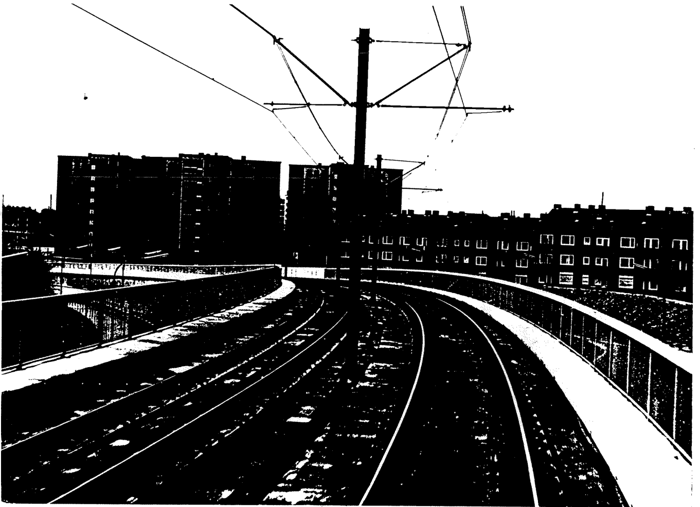
TRONCON DU RING EN VIADUC SUR LA LIGNE 13 : ON REMARQUE L'IMPLANTATION DES SUPPORTS DE LA CATENAIRE ET LES 2 FEEDERS COTE A COTE QUI SUPPORTENT LA LIGNE DE CONTACT .
