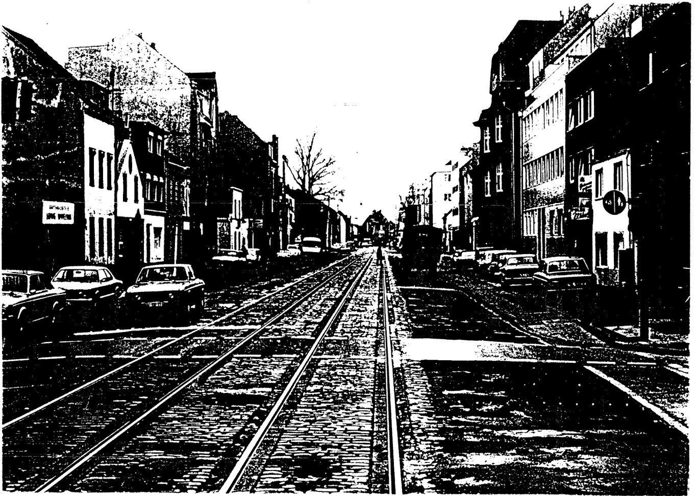
VOIES NOYÉES EN SITE BANALISÉ SUR LES LIGNES 6 ET 9
