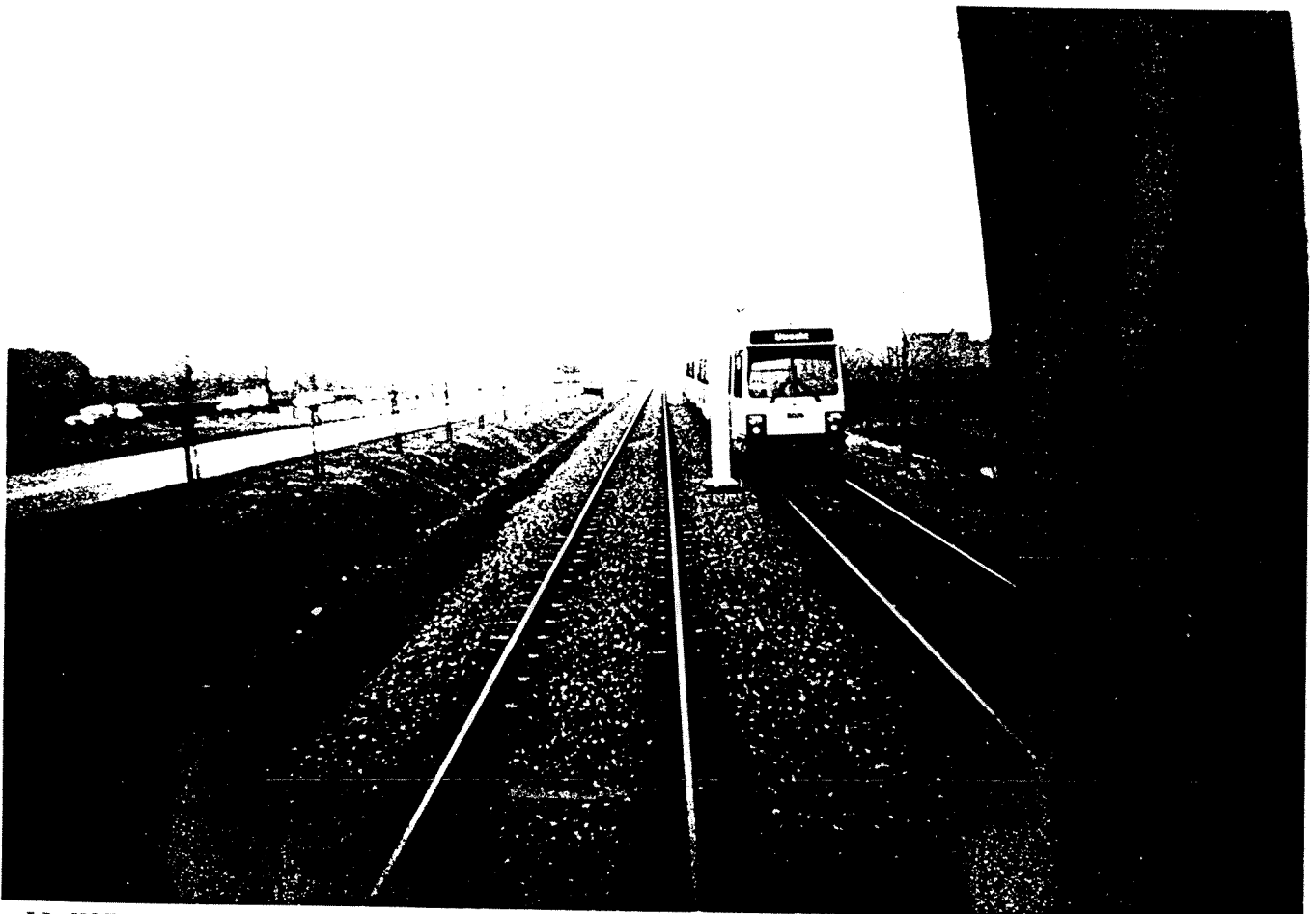
LA VOIE NOUVELLE SUR BALLAST EN SITE SEPRE LE LONG DE L'AVENUE RELIANT NIEUWEGEIN A UTRECHT
