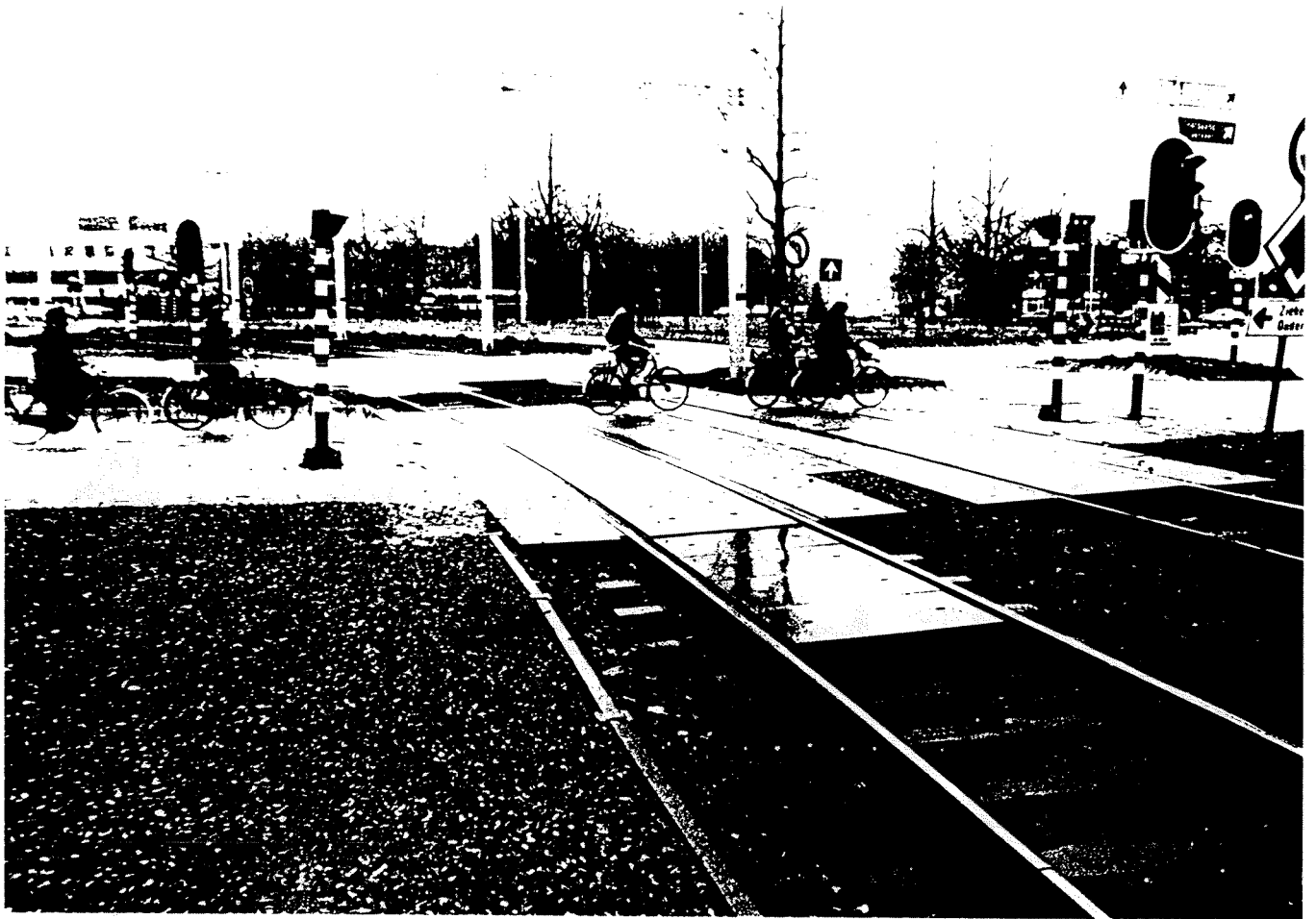
UN PASSAGE POUR CYCLISTES AU DROIT D'UN CARREFOUR : ON REMARQUE LES PLAQUES PREFABRIQUEES EN BETON QUI ASSURENT LE PASSAGE POUR PIETONS, CYCLISTES ET AUTOMOBILISTES CE QUI PERMET D'ASSURER LA CONTINUITE DES RAILS VIGNOLE
