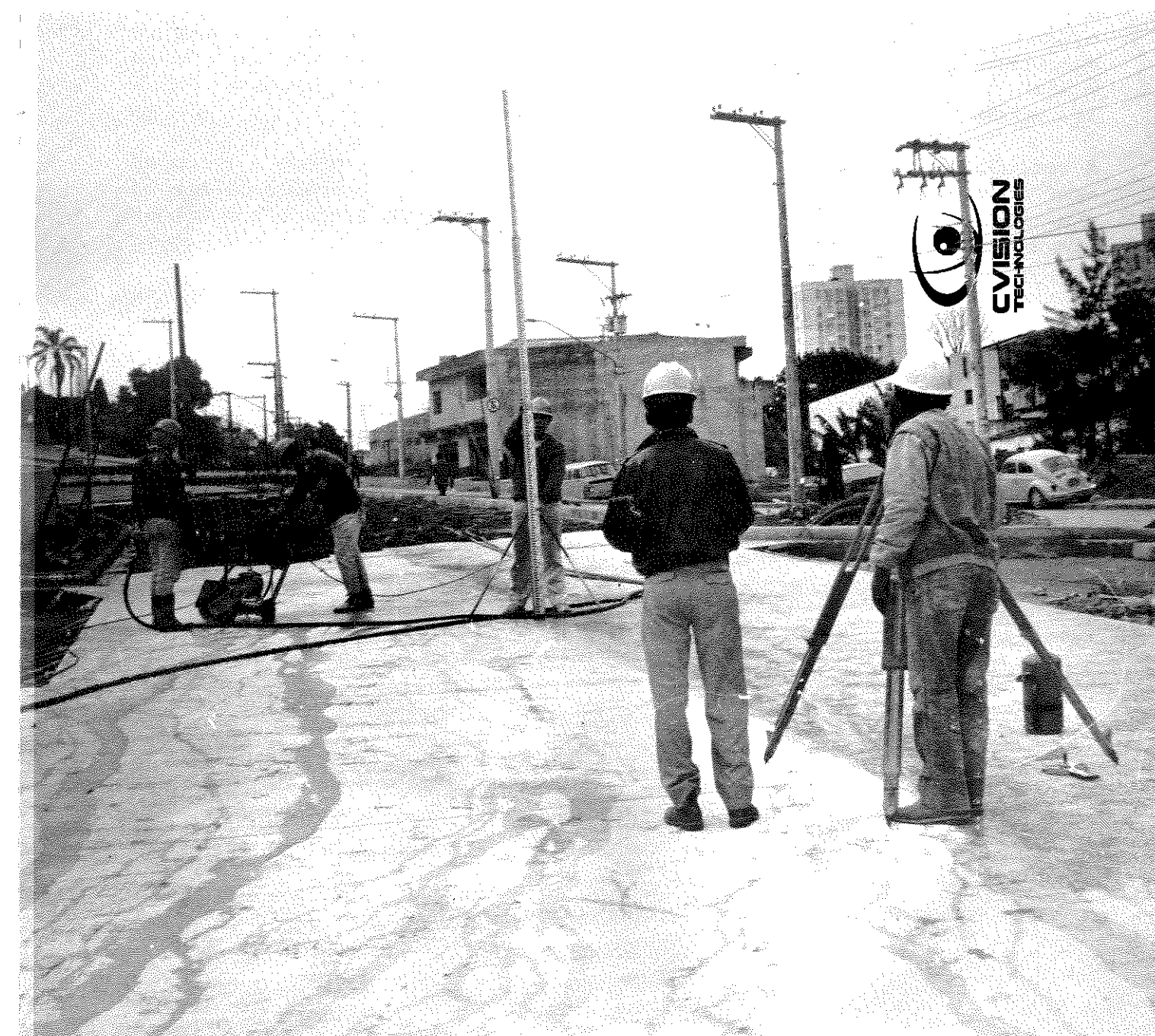
A MATERIALIZAÇÃO DO PROJETO SE INICIA COM A LOCAÇÃO TOPOGRÁFICA DO EIXO DA OBRA. LA MATERIALIZACION DEL PROYECTO COMIENZA CON LA LOCALIZACION TOPOGRAFICA DEL EJE DE LA OBRA.
