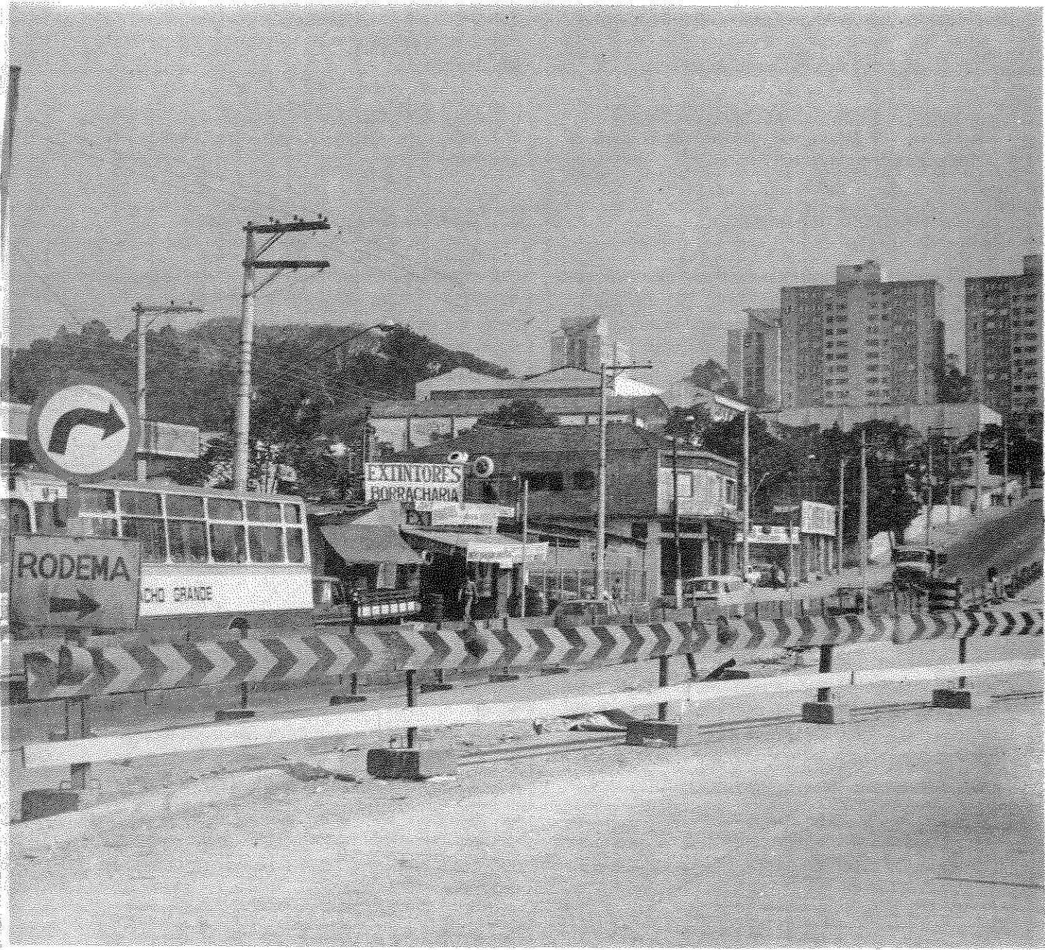
DEVE-SE GARANTIR A SEGURA CIRCULAÇÃO DE VEÍCULOS E PEDESTRES DE FORMA A ELIMINAR OS CONFLITOS DESTES COM A OBRA. DEBE GARANTIZARSE UNA CIRCULACION SEGURA DE VEHICULOS Y PEATONES PARA ELIMINAR LOS CONFLICTOS CON LA OBRA.
