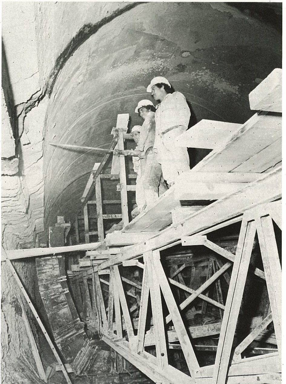
Réalisation d'une perforation à partir de la passerelle du coffrage aux fins de blocage de la voûte bétonnée du tunnel. Ce blocage est réalisé par des injections faites à partir de l'intérieur du tunnel.
