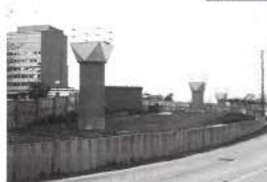
Les piles sont terminées et la construction du tablier est commencée.
