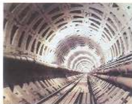
Un exemple de souterrain en chantier construit selon la même méthode que le lot 3 : le tunnel du métro d'Amiens.
