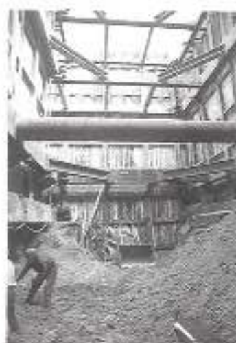
Méthode de réalisation du tunnel voûté.
