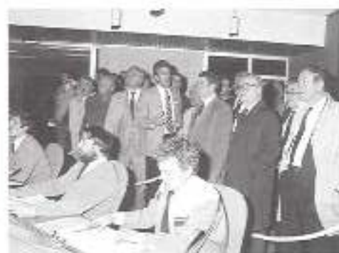
La délégation des élus et techniciens de la Communauté Urbaine de Strasbourg au Poste de Contrôle et de Commande.
