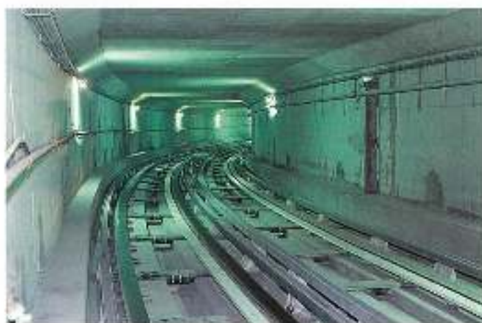
Le tunnel terminé et équipé sous le boulevard Montebello.
