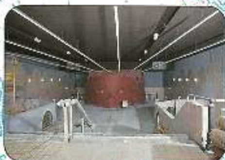
La station "Port de Lille" en cours d'aménagement.
