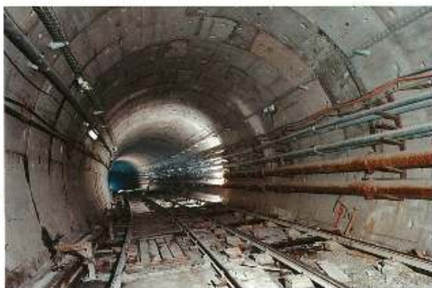
Le tunnel terminé sous l'avenue de Dunkerque.
