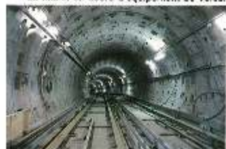
Le tunnel en cours d'équipement de voies.
