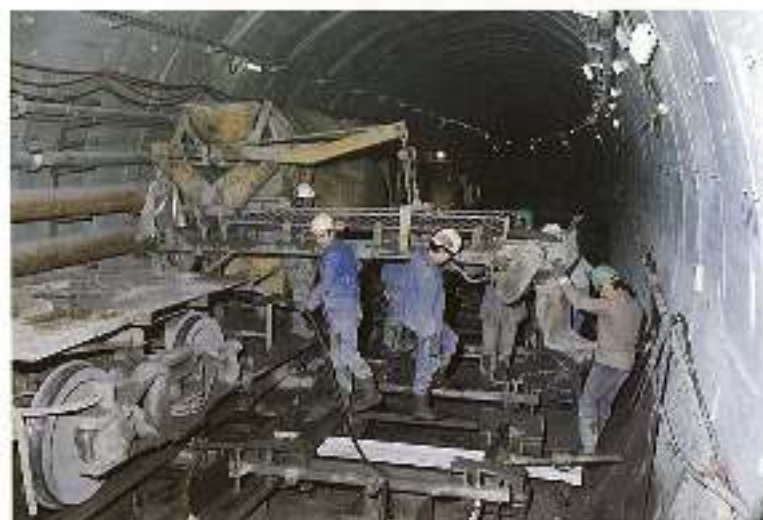
L'équipement de voies du tunnel en cours de pose.
