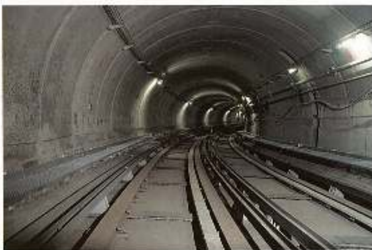
Le tunnel terminé et équipé
