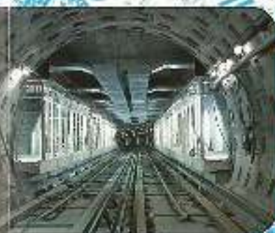
Vue du tunnel et des quais de la station "Mairie de Lille".
