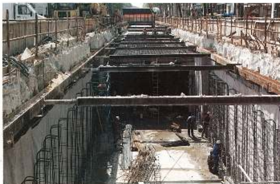
Les travaux de creusement en tranchée le long du boulevard Montebello.
