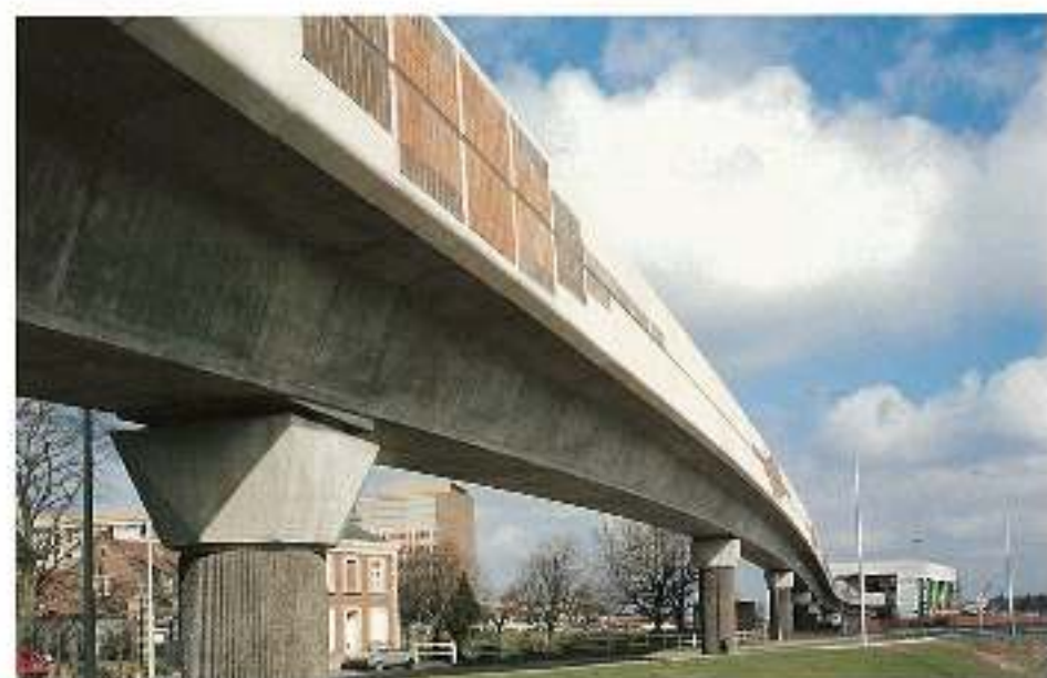
Le viaduc à proximité de l'Hôpital Saint-Philippe.
