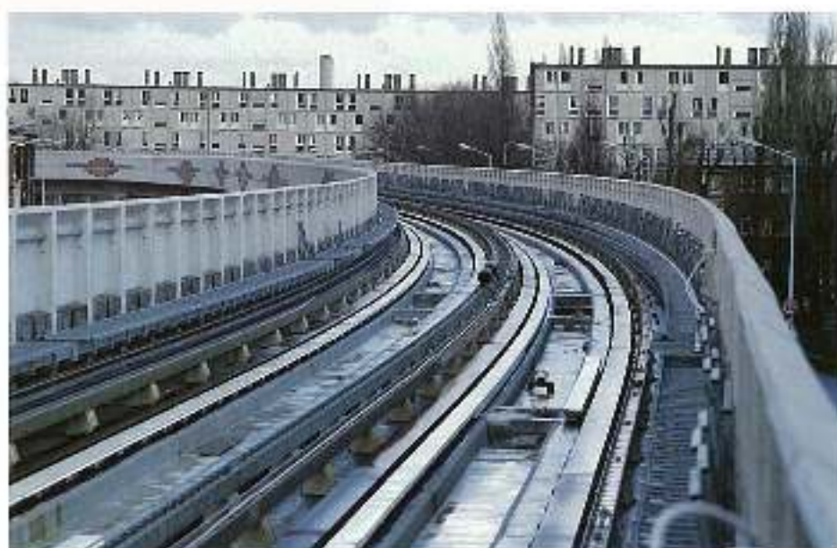
Les équipements de voies sur le viaduc, le long du boulevard de Bellart.
