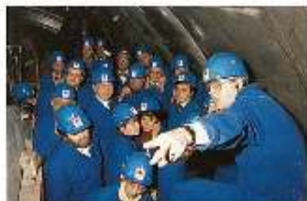
Visite du tunnel en construction par les élus et techniciens de GENEVE.
