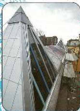
La verrière en surface de la station « Foire Commerciale ».
