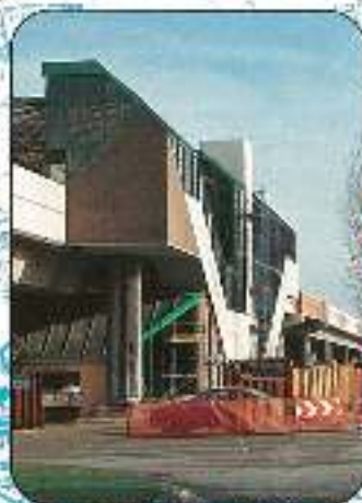
Vue extérieure de la station "Porte d'Arras".
