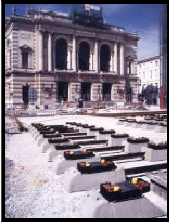
Figure 4 : Pose de traverse, Place de la comédie à Montpellier, Sateba
