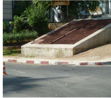
Fig 4 : Jardin d'essai, vue sur un deuxième ouvrage d'extraction d'air du métro dont les murets sont d'une hauteur > 50 cm entre la rue Laveran et Belouizdad Mohamed
