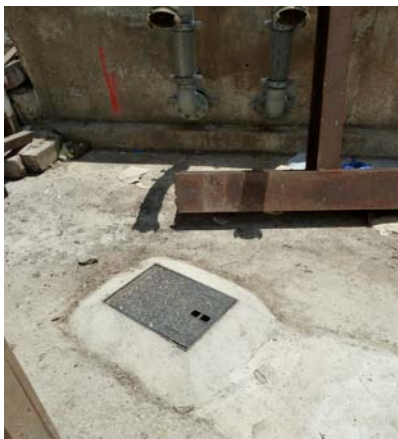
Fig. 55 : Station Khalifa Boukhalfa : sortie des colonnes sèches pour les pompiers
