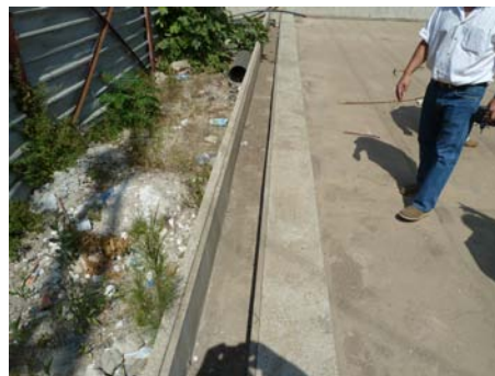
Fig. 27 : Récupération de l'eau de pluie par ce caniveau, sur la droite accès vers l'entrée sud de la station Cité mer et soleil
