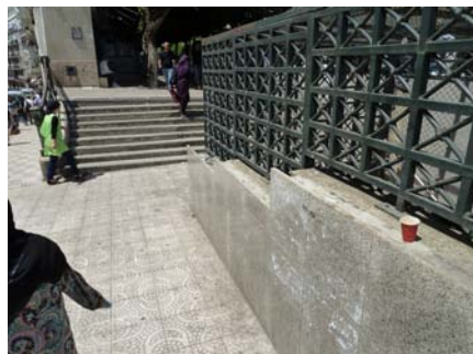
Fig. 51: Entrée de la station Tafourah Grande Poste (cf. photo 45), depuis le rue Emir El Khettari les abords sont en pente ce qui est favorable au ruissellement des eaux de pluie hors de la station
