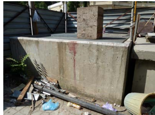
Fig. 6 : Station Jardin d'essai, ouvrage d'extraction d'air surélevé d'une hauteur d'environ 1,00 mètre au dessus du niveau de la rue Belouizdad Mohamed
