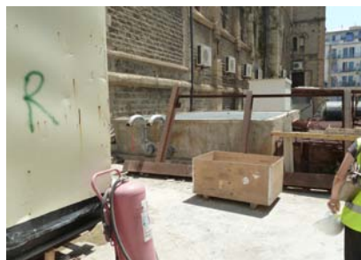
Fig. 53 : Ouvrage d'extraction d'air surélevé au dessus de la station Khalifa Boukhalifa
