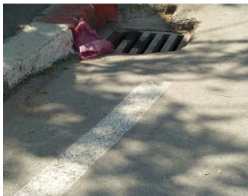
Fig. 3 : Jardin d'essai, vue sur une grille avaloir dans la rue Belouizdad dont le niveau est inférieur à celui du seuil d'entrée à la station
