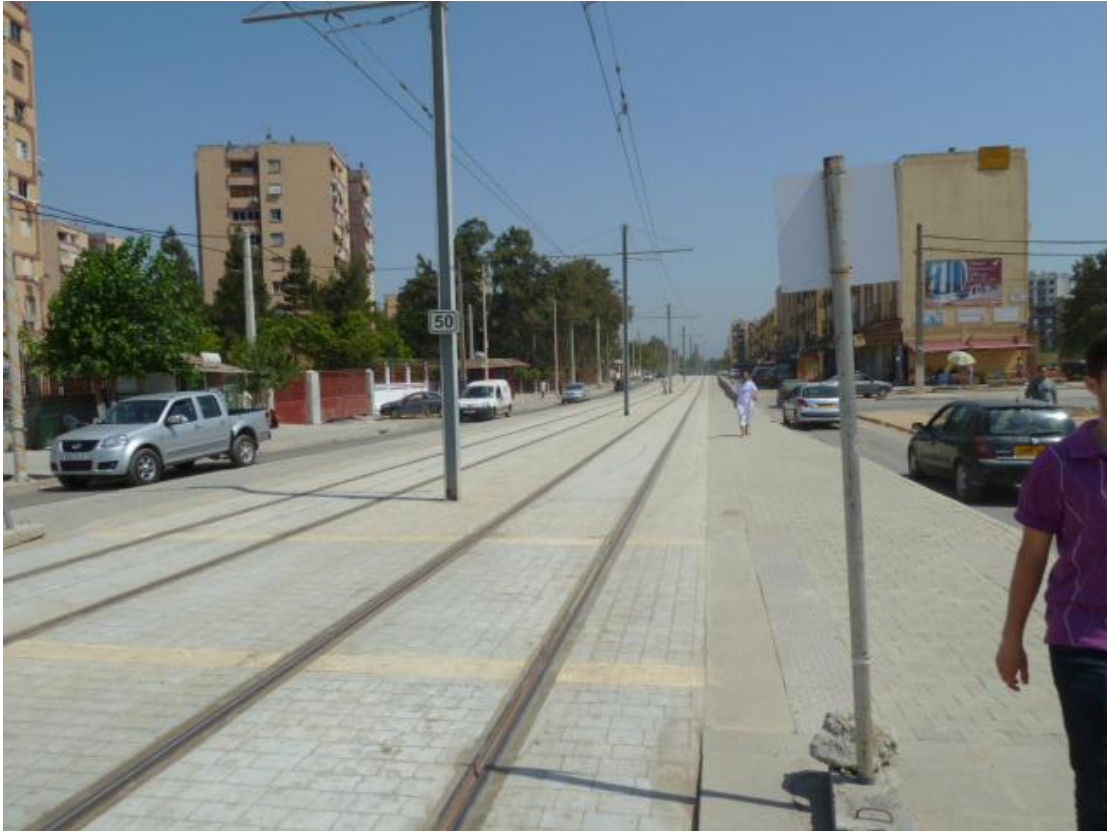
La voie en service revêtue de béton et dessin de pavés
