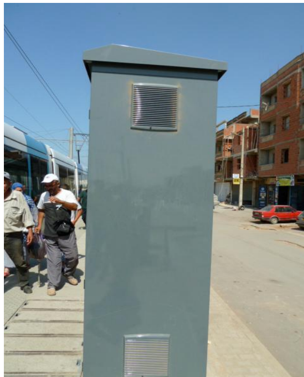
Armoire électrique réfrigérée
