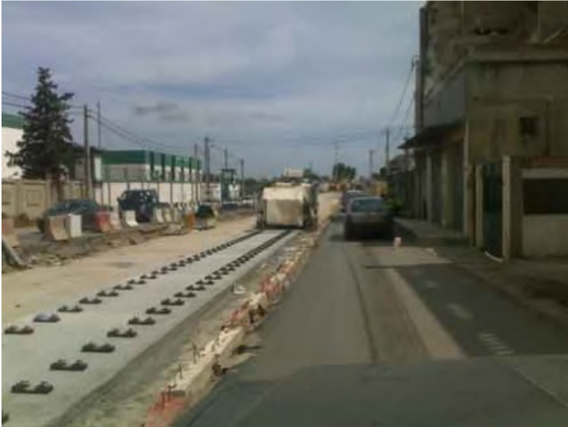
Voie sur dalle selon la méthode APPITRACK (ALSTOM) Entrée rue de Tripoli depuis La Farge
