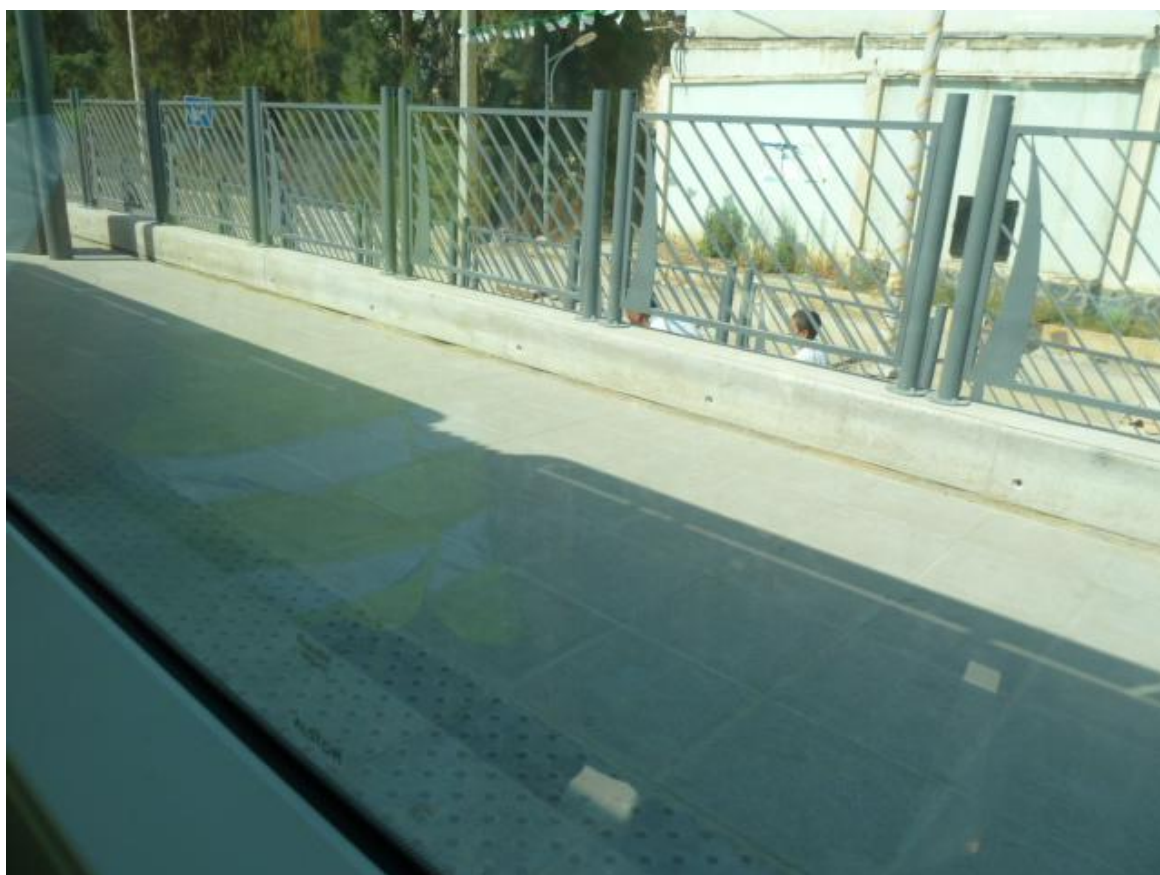
Pose de bande podotactile pour guider les malvoyants
