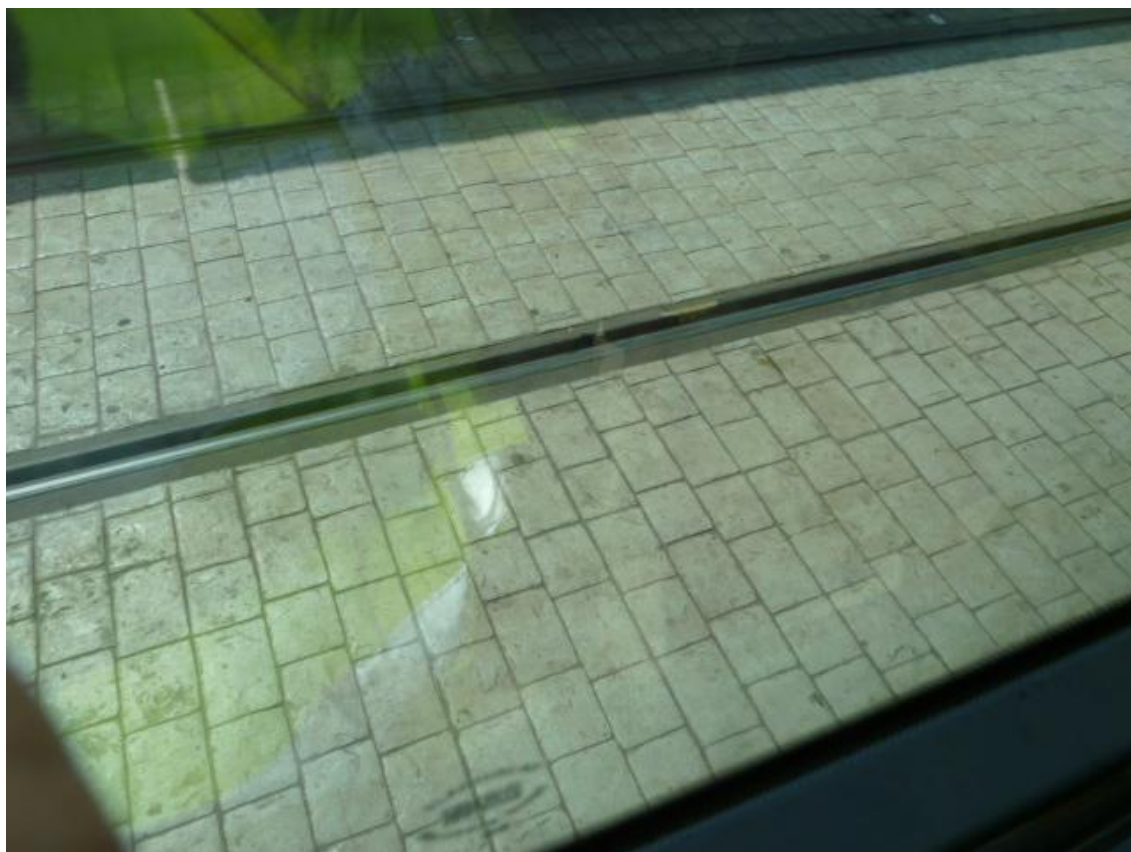
Niveau de finition du revêtement de la voie bétonnée
