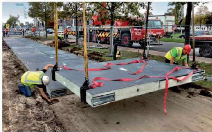
Figure 16 : Installation des panneaux sur la route [28].
