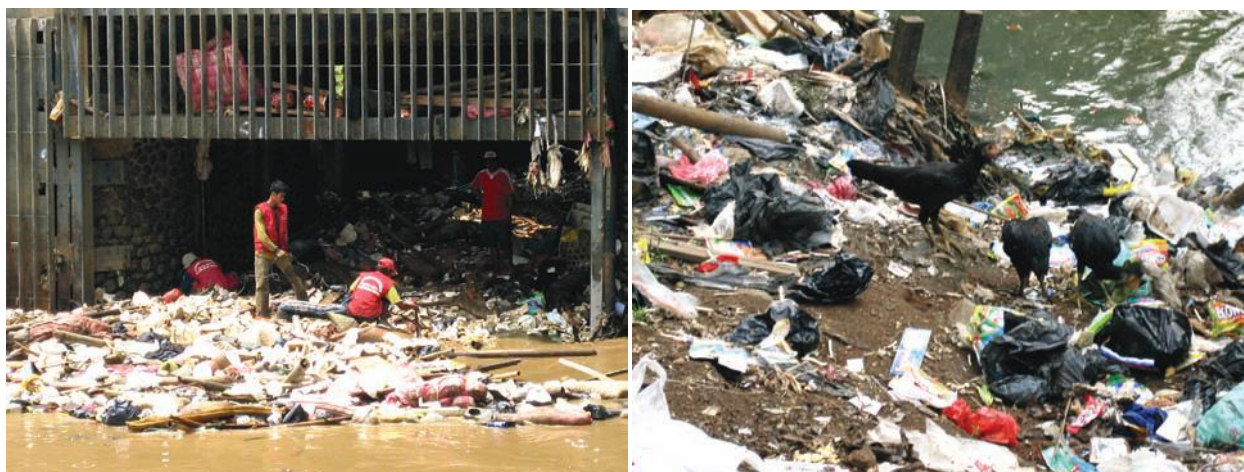
Figure 7.11. Engorgement de la Ciliwung par les déchets ménagers. A gauche : vanne de Manggarai juste après les inondations de février 2007. A droite : déchets sur la berge à Bukit Duri (cliché P. Texier, février 2007).
