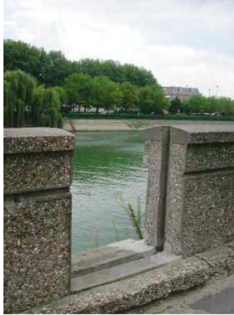
FIG. 1.1 : Murette anti-crue et emplacement du batardeau (Courbevoie)
