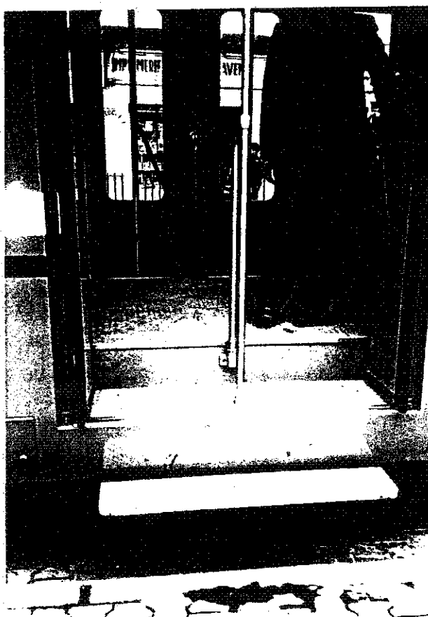
Photo 11 : Niveau d'accès du métro à Tunis: ici quai de 60 cm (par rapport au niveau du rail) pour un niveau du plancher du véhicule à 85 cm au dessus du rail.
