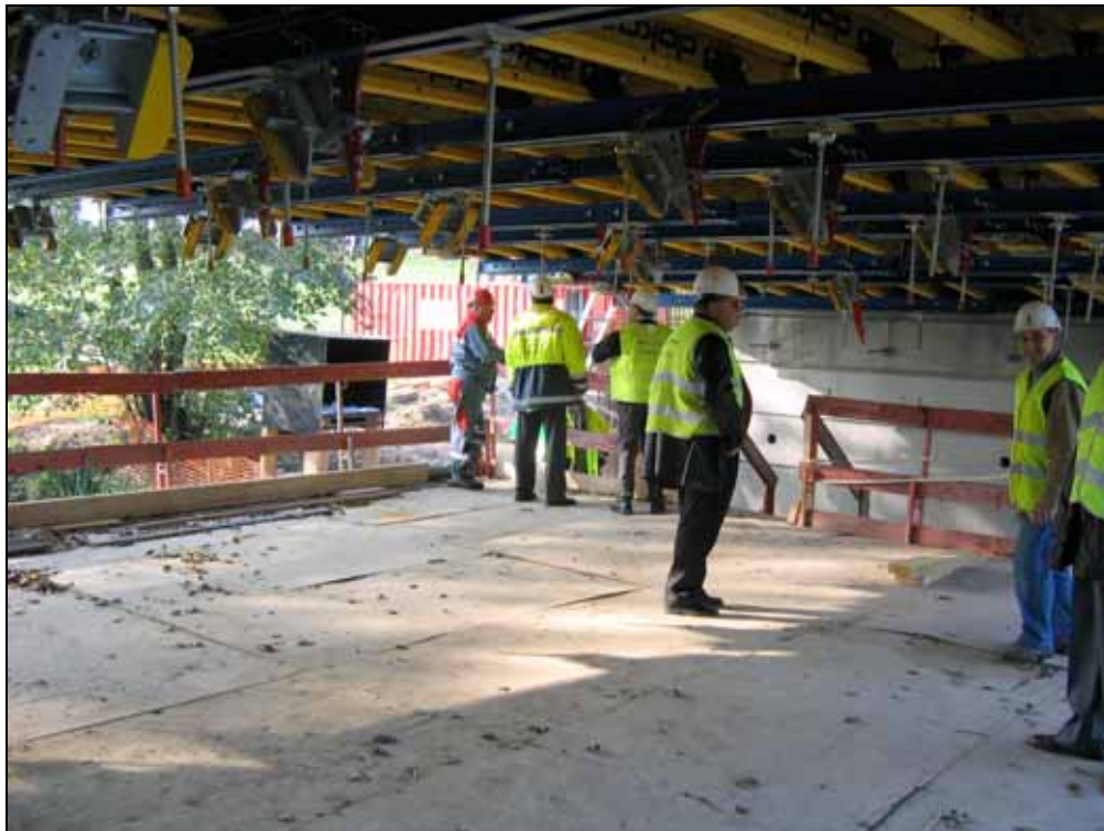
Coffrage mis en place sous le futur tablier du pont-rail en cours de construction au PK 3,546
