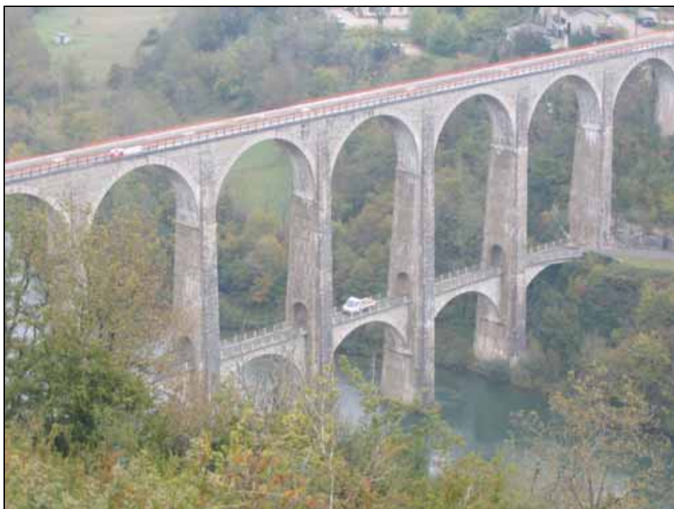
Viaduc de Cize ou de la Valserine le tablier supérieur pour la voie ferrée, le tablier inférieur pour la circulation routière
