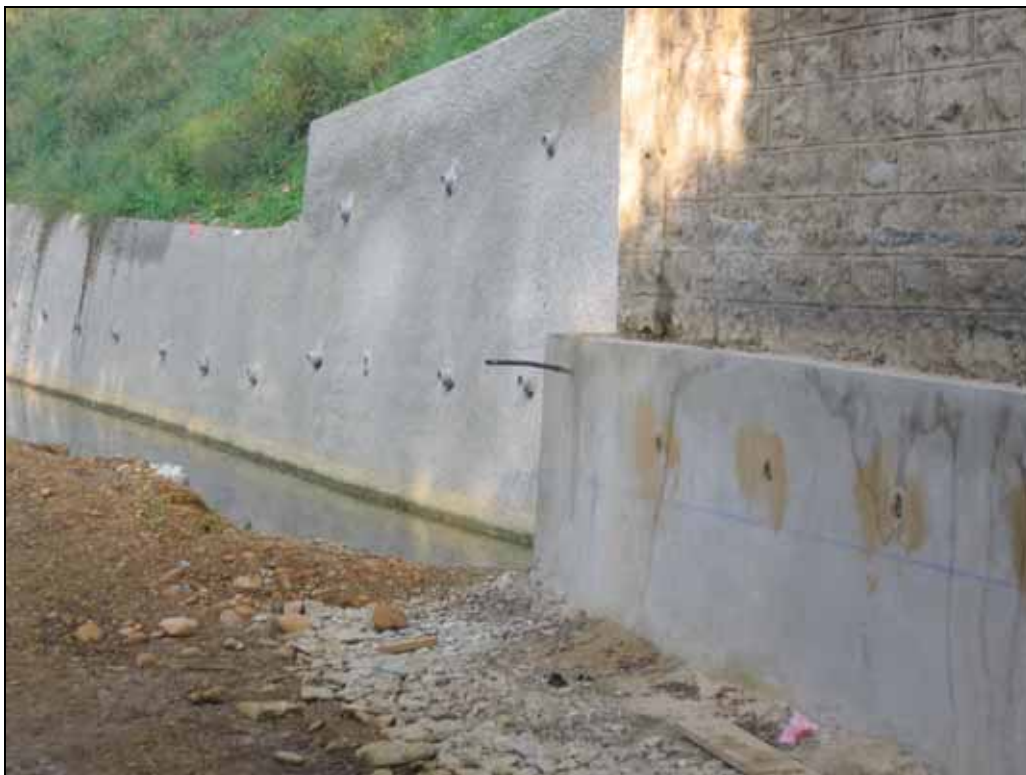
Confortement des fondations du PR 0, et murs de soutènement avec barbacanes
