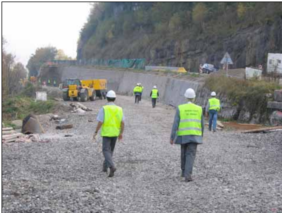
Réalisation d'un mur de soutènement de hauteur variable avec une route circulée au-dessus
