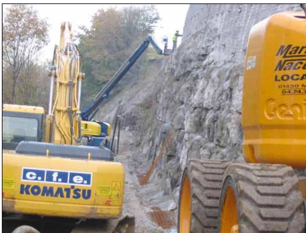
Vue d'un éboulement du soutènement ancien repris par un nouveau mur constitué de 2 nappes de ferrailage et de béton projeté en plusieurs couches
