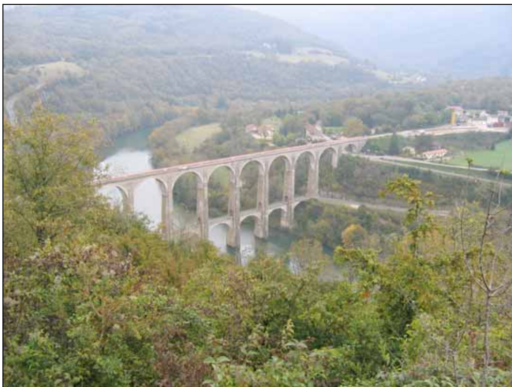
Viaduc de la Valserine à 11 arches de 157 m de long et 42 m de haut enjambant l'AIN
