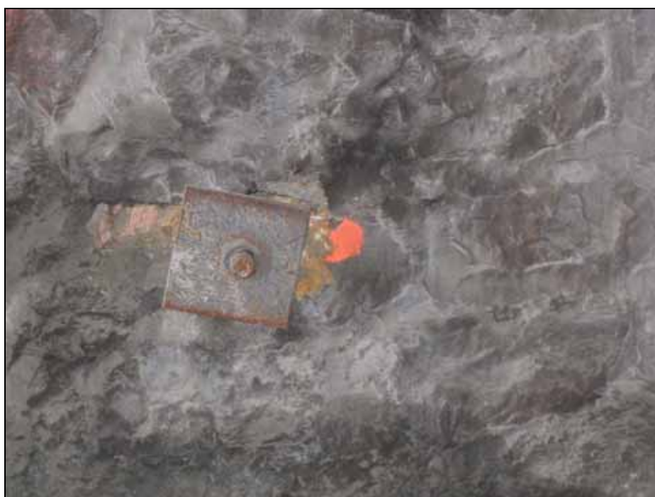
Tête de tige filetée enfoncée sur 1,50 m pour tenir la paroi
