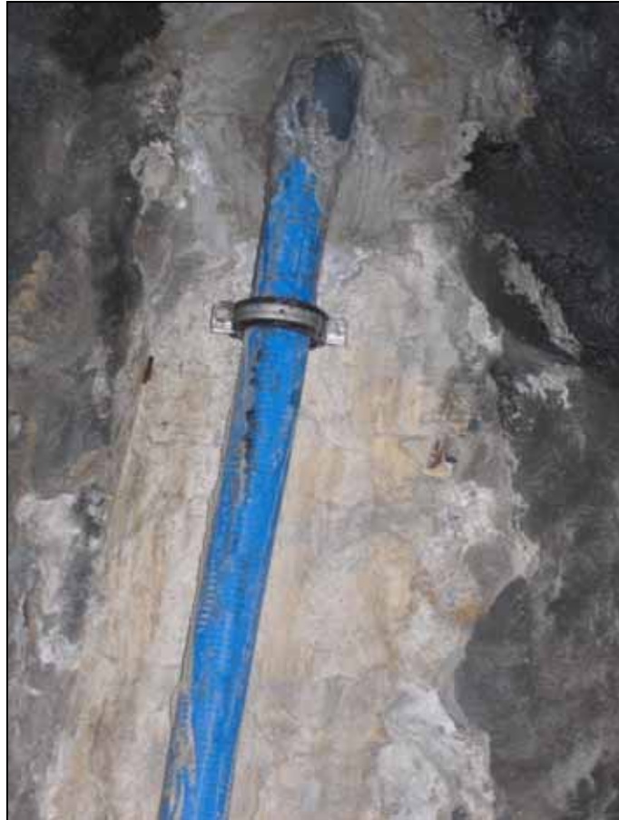
Évacuation d'une venue d'eau en voûte, amenée vers le caniveau latéral
