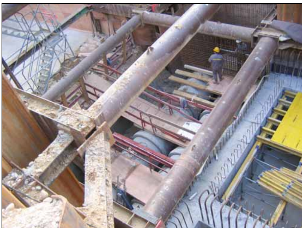
Déviations des réseaux existants sous la future voie ferrée au pont routier en construction PK 2,455
