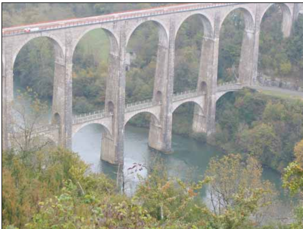
Viaduc de Cize ou la Valserine à 11 arches de 20 m de 157 m de long enjambant l'AIN à la fin du lot 1
