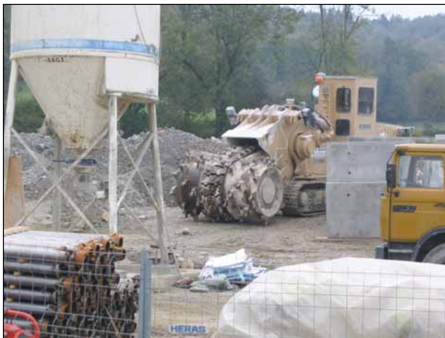
Engin de déroctage du radier du tunnel en vue de son abaissement
