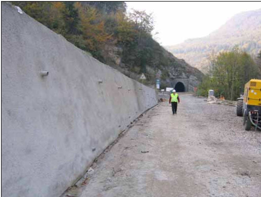
Vue sur le mur de soutènement constitué de deux nappes de ferrailage
