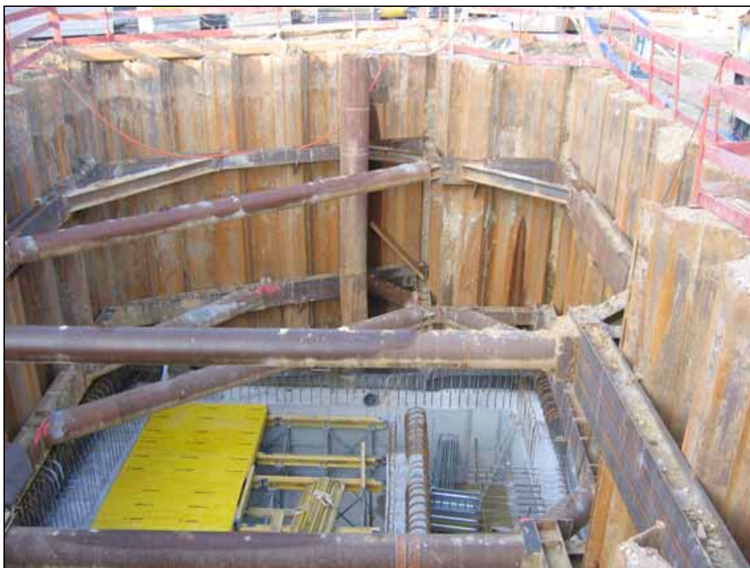
Vue d'une fosse de recueil des eaux de ruissellement en vue de leur pompage au PK 2,455
