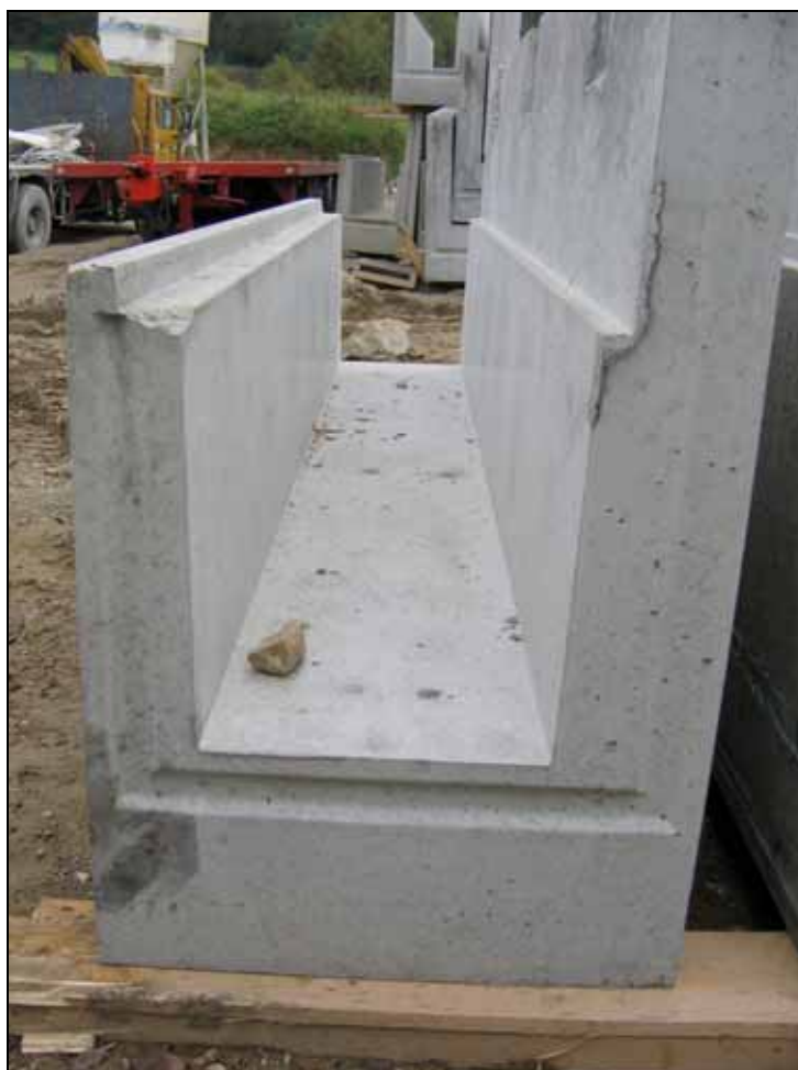
Caniveau préfabriqué à poser en pied de voûte du tunnel pour reprendre les eaux
