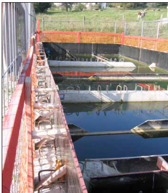
Bassin de décantation des eaux de ruissellement en sortie de tunnel qui servira ultérieurement de réserve d'eau pour les secours incendie
