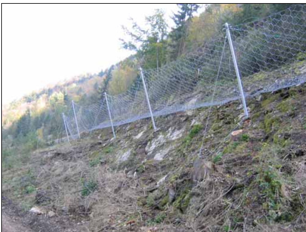
Système de protection par filets dynamiques qui sera complété par des filets détecteurs
