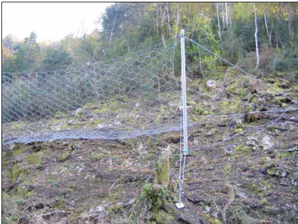
Système de protection par filets dynamiques qui sera complété par des filets détecteurs
