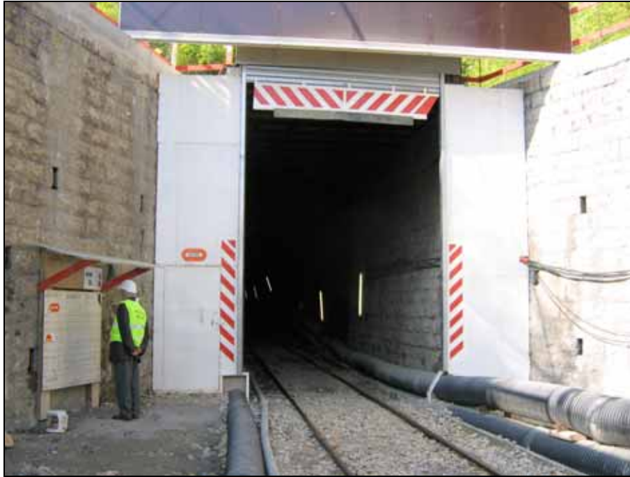
Entrée du tunnel de Mornay avec tuyau d'évacuation des venues d'eau durant le chantier de reprise des parois
