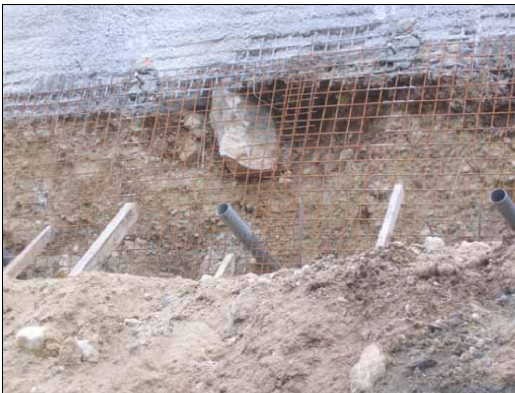
Vue d'un éboulement du soutènement ancien repris par un nouveau mur constitué de 2 nappes de ferrailage et de béton projeté en plusieurs couches
