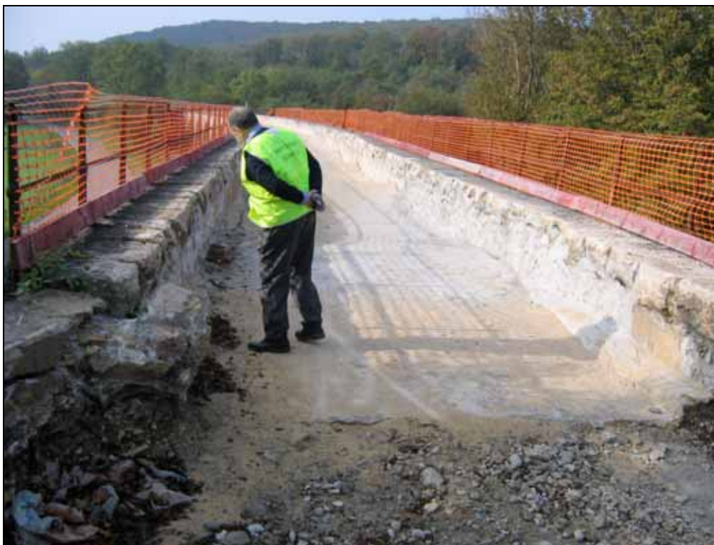
Viaduc de la Ramasse PK 15,079 à 15,218 dont la maçonnerie des voûtes est dégagée
