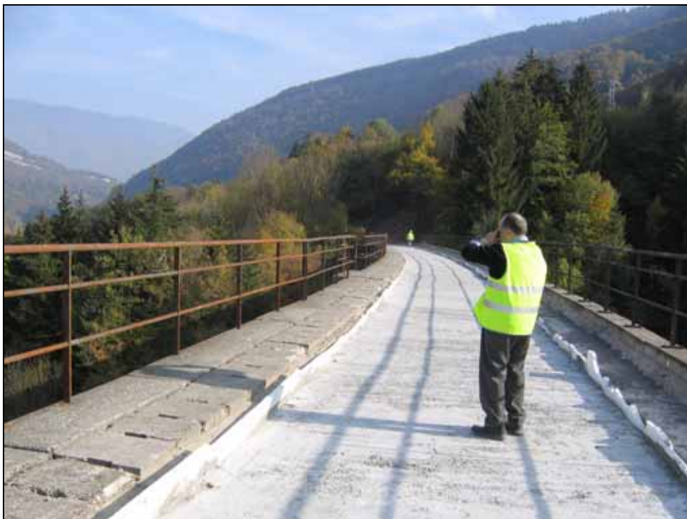
Le tablier du viaduc du Tacon est prêt à recevoir l'armement de la voie
