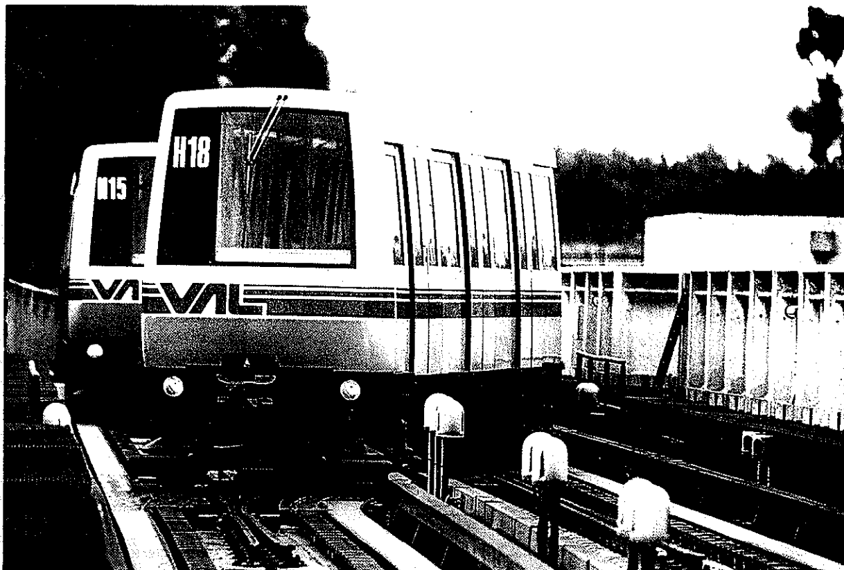
Figure 20: VAL de LILLE: Un élément s'engage sur un tronçon de voie au droit d'un détecteur de présence du train.
