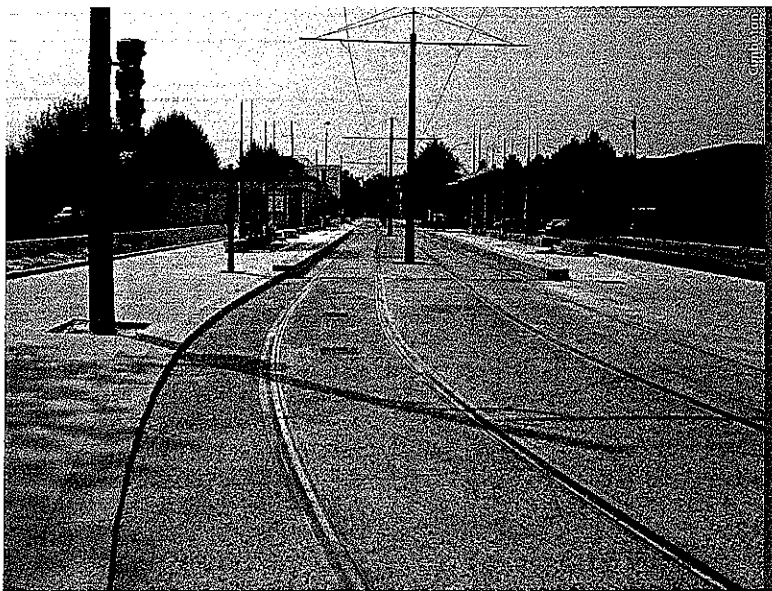
▲ Photo 2 Revêtement de plates-formes de tramway en béton désactivé ▲ Tramway platform surfacing in deactivated concrete
