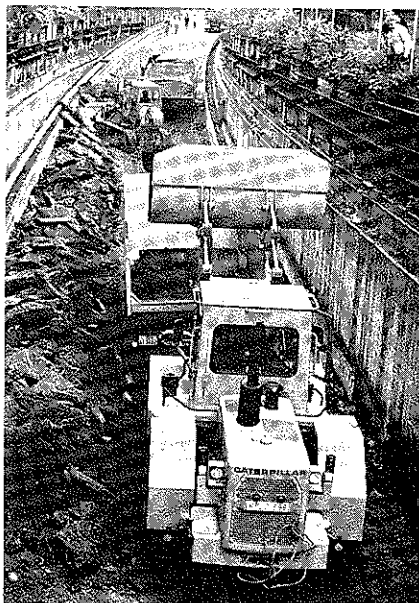
Bild 2: Bitumendecke und Kieskeil werden ausgeräumt
