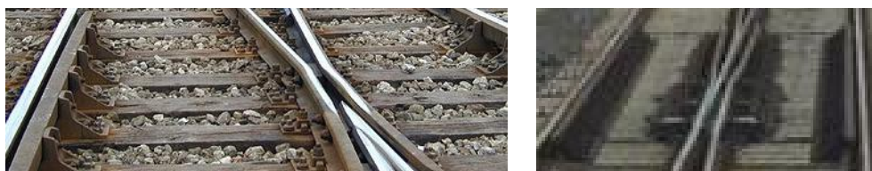
FIG. B.1 – Coeur d'aiguillage : normal et mobile
