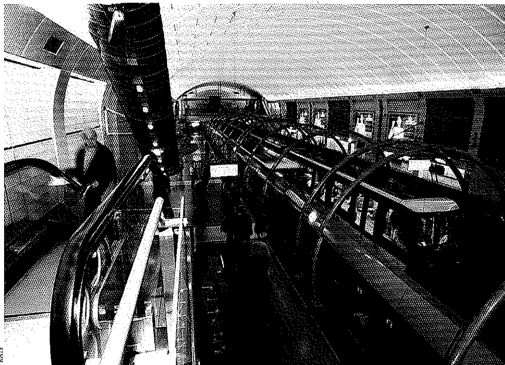
STATION CHÂTELET: LES QUAIS, LES PORTES PALIÈRES
