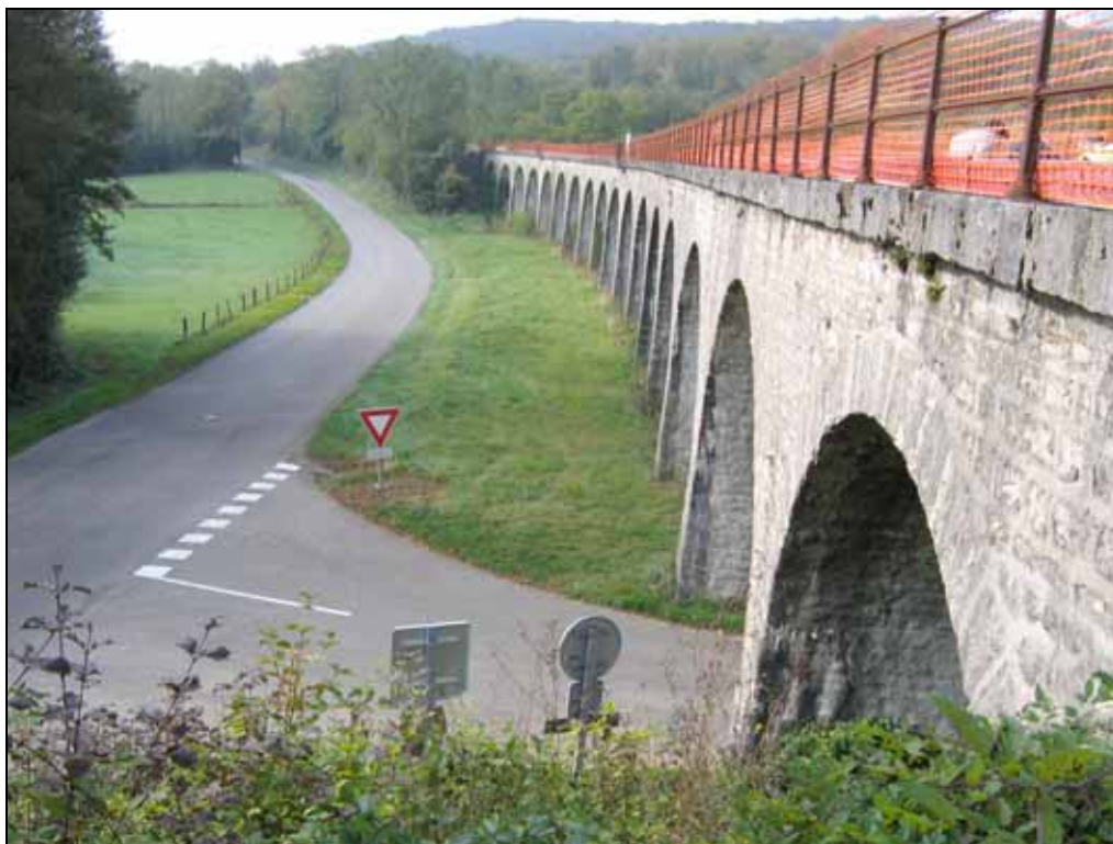
Vue des 17 arches de 7 m du Viaduc de la Ramasse
