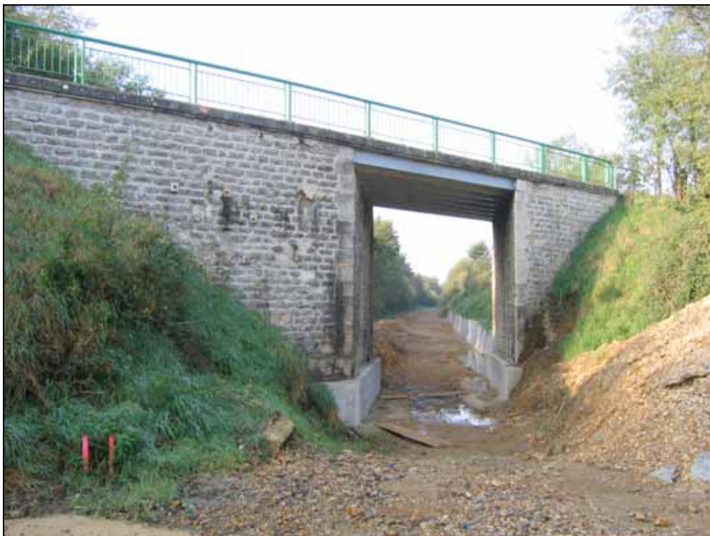
Abaissement de la plateforme sous le PR0 au PK 3,401
