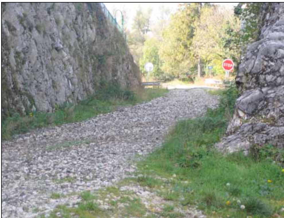
Vue sur un passage à niveau dont la vue devrait être dégagée du bloc rocheux de droite
