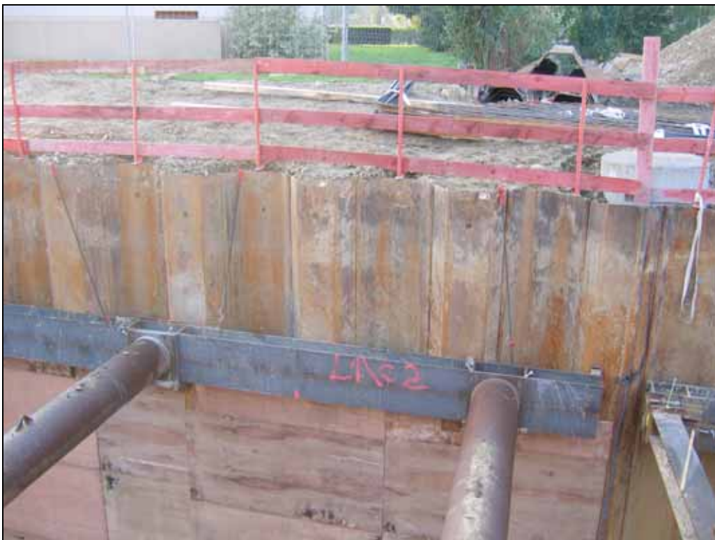
Pose des panneaux de coffrage avant l'étanchéité, le ferrailage des pieds droits de la trémie
