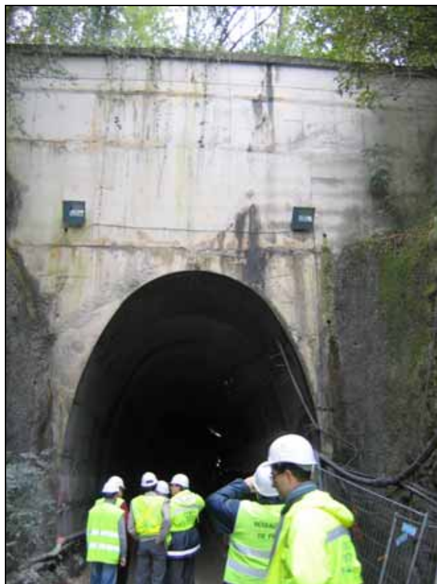
Entrée du tunnel de la Racouze
