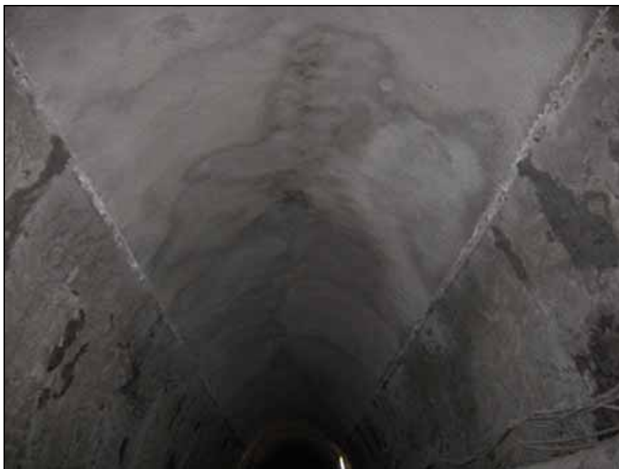
Reprise de la voûte avec projection de béton
