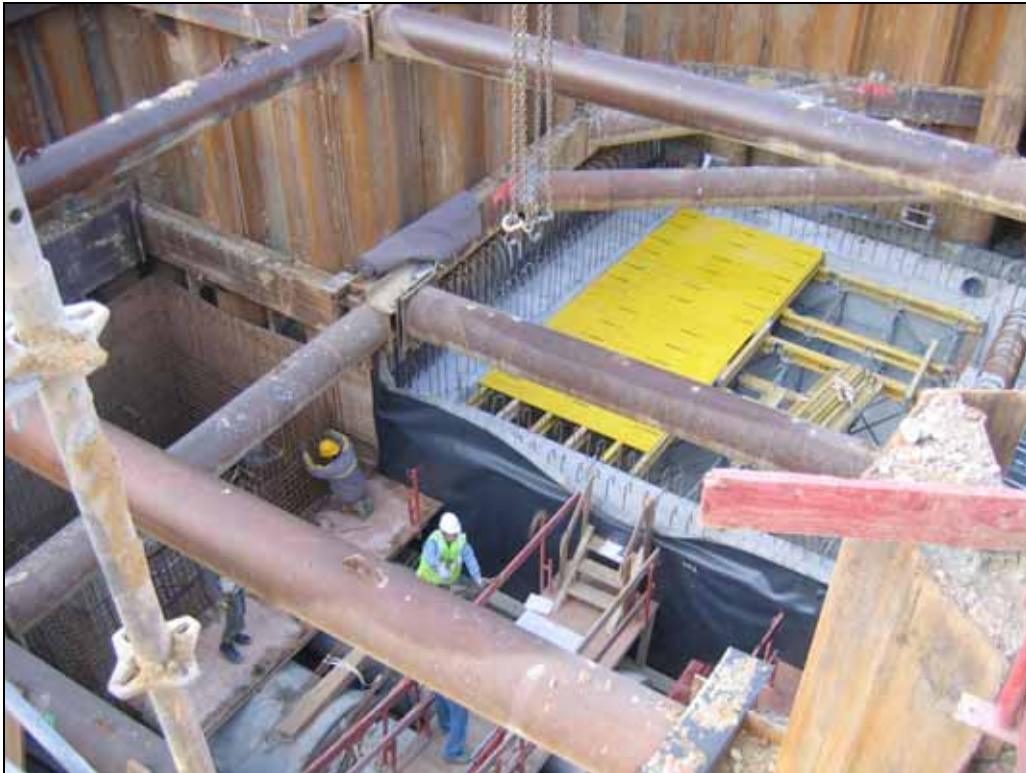
Pose de protection étanche autour de l'ouvrage de recueil des eaux sous la trémie de la RN 75
