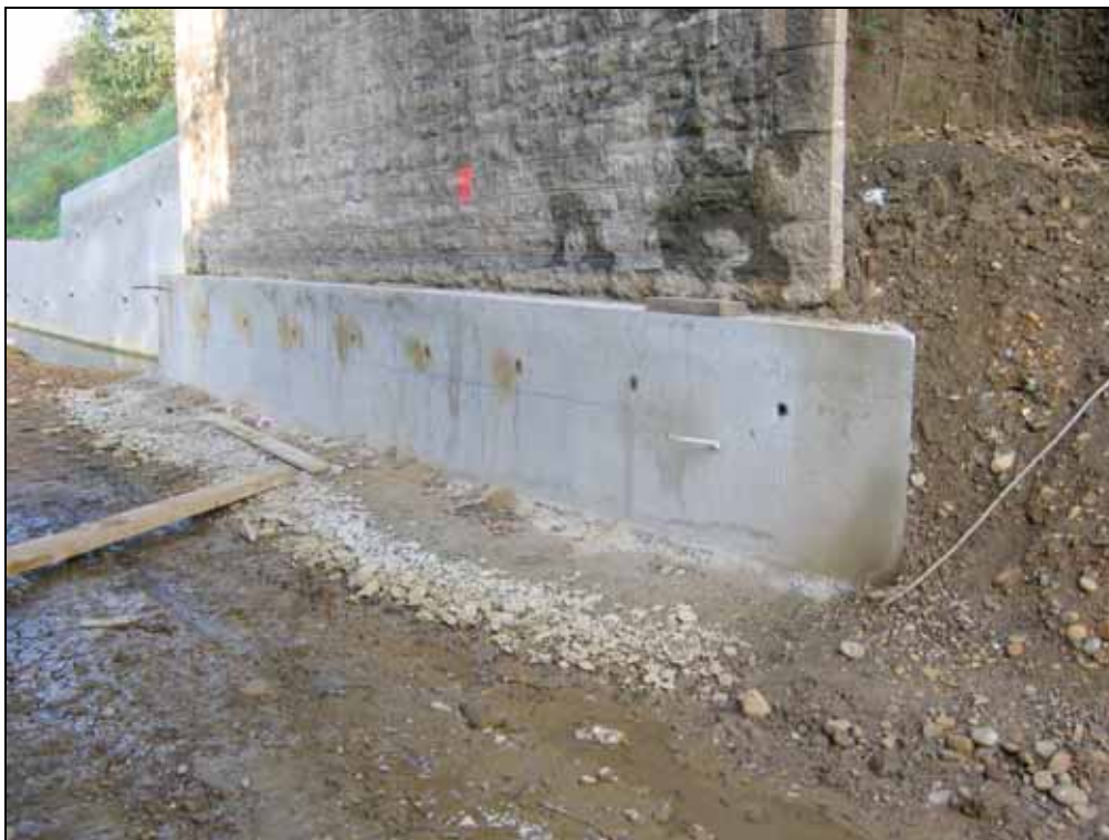
Fondations du PR 0
