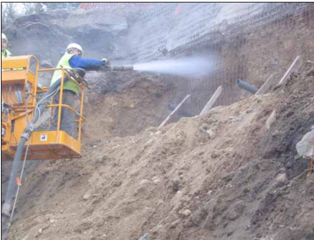
Projection du ciment et sable sous 5 bars de pression et humidifié en sortie du tuyau
