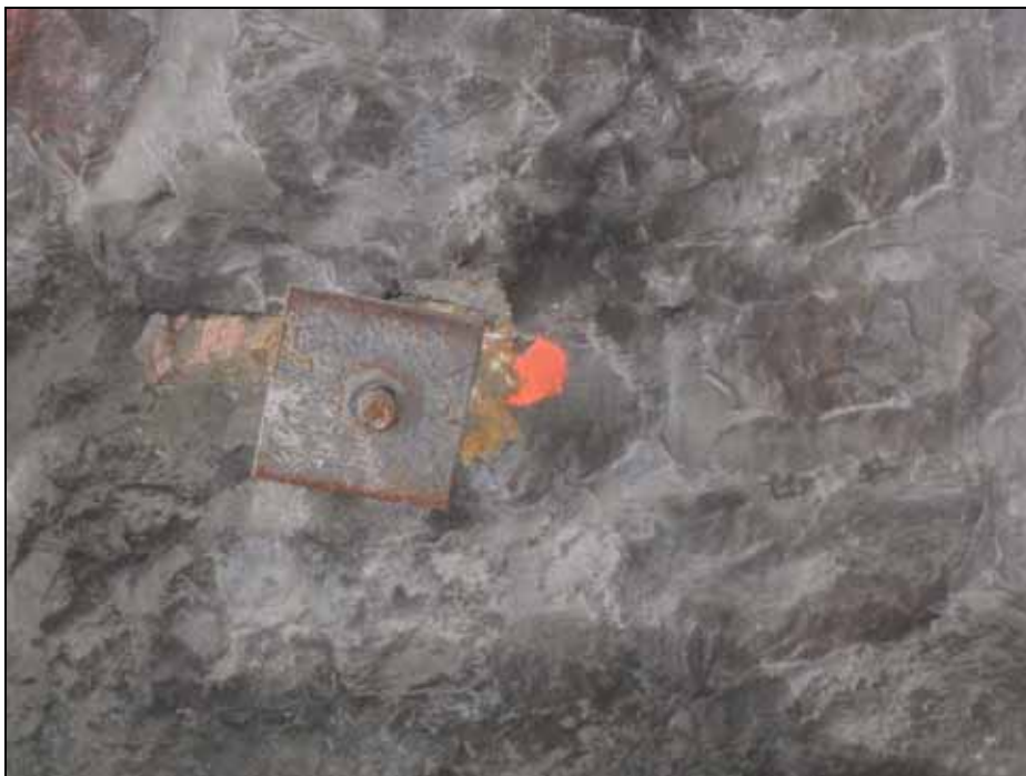
Tête de tige filetée enfoncée sur 1,50 m pour tenir la paroi
