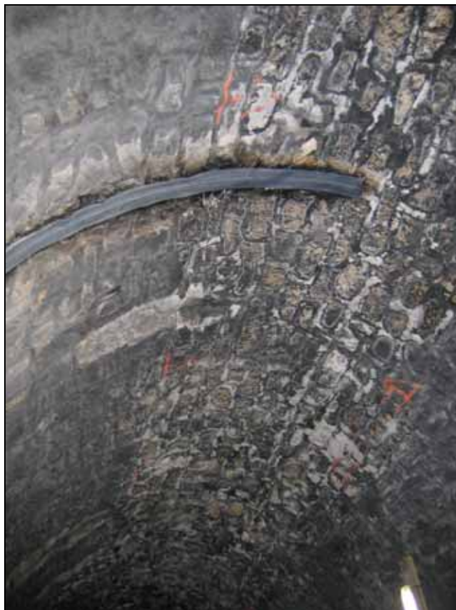
Reprise d'une fuite en voûte
