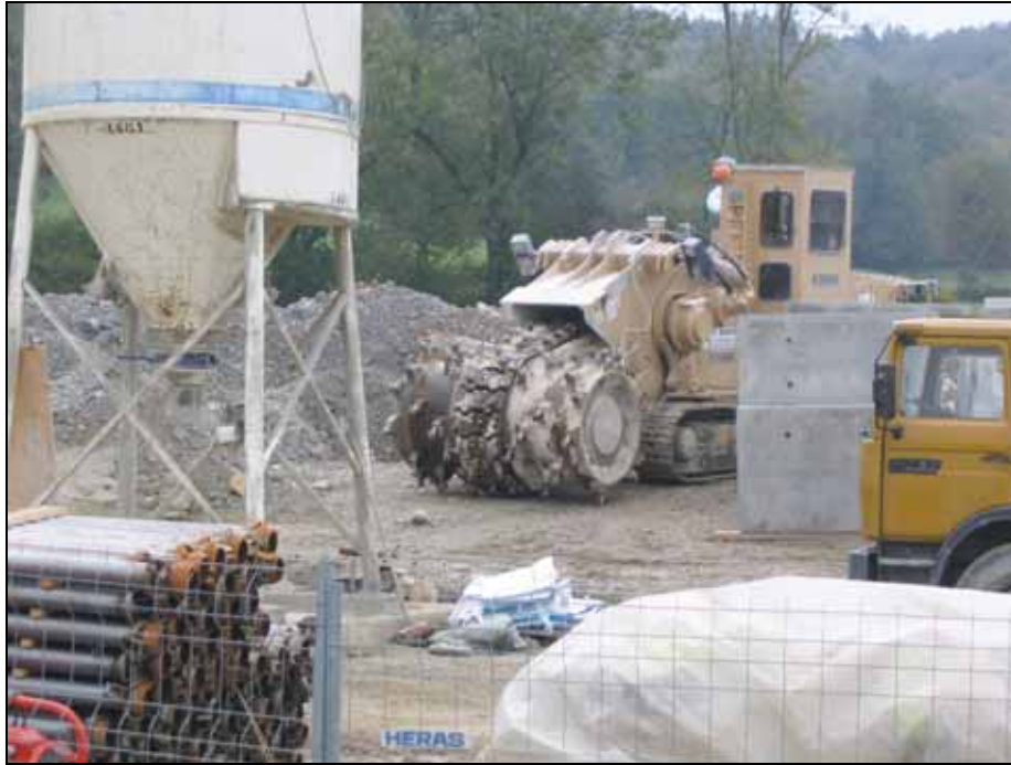
Engin de déroctage du radier du tunnel en vue de son abaissement
