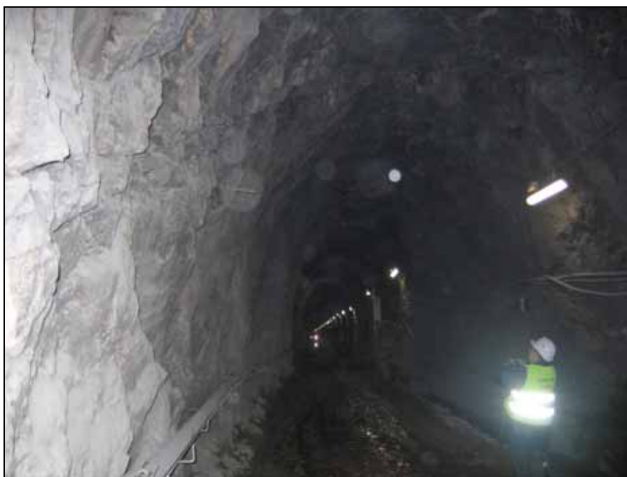
Vue de la voûte du tunnel
