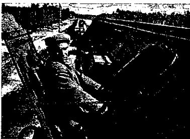
A proximité de Tioumen, les constructeurs ont dû travailler dans un des secteurs les plus marécageux du tracé. La voie est mise en place par coupons préfabriqués avec travelage en bois.
