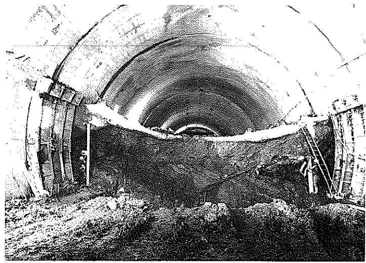
Coffrage des piédroits par plots. Vue du radier provisoire. Tunnel de Las Planas, A 8 (Photo Y. Collet)
