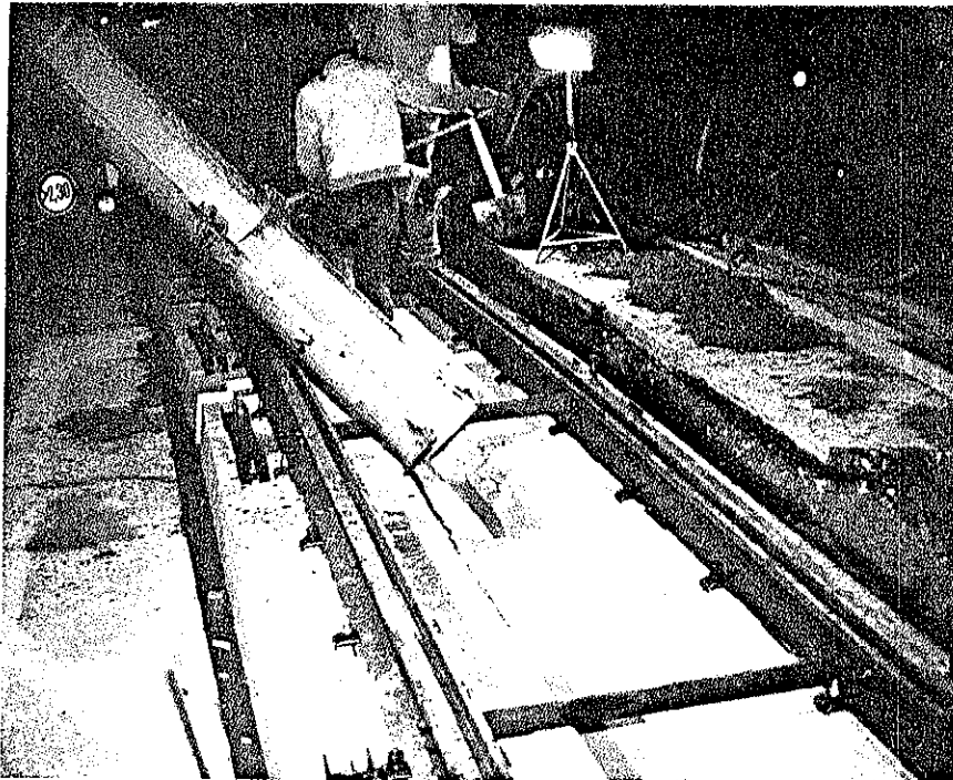
Bild 6: Nach dem Anheben der Platten bis unter die gerichteten Schienen und deren Befestigung wird der flüssige Mörtel (50–80 mm) eingebracht. Die Platten sind also in einem durchgehenden Mörtelbett eingebunden.
