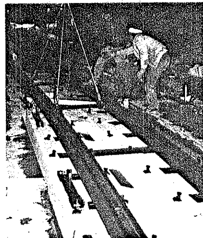
Bild 5: Die Schienen, bereits mit den Spurstangen verbunden, werden auf die Betonklötze abgesetzt, gerichtet und an beiden Enden mit dem bestehenden Geleise verbunden.
