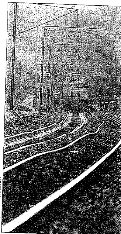
Une fois le ballast nettoyé et complété, les voies anciennes sont enlevées pour céder la place à de nouveaux rails et traverses.
