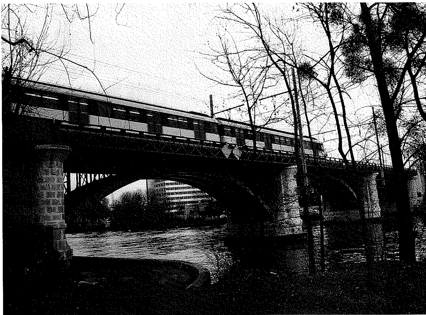
Le pont avec ses nouvelles arches et nouveaux tabliers.
