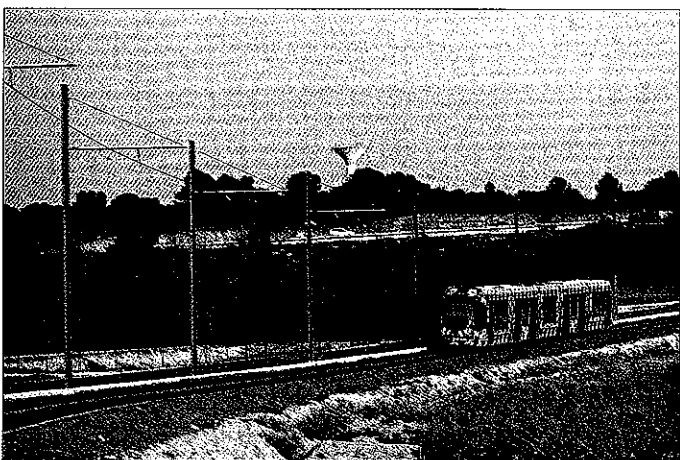
Der nordöstliche eingleisige Abschnitt der Linie 2 führt kurz vor der Endhaltestelle Jacou auf Vignolschienen durch Weinfeldern. Parallel zur neuen Straßenbahnstrecke wurde ein Fuß- und Radweg angelegt.
