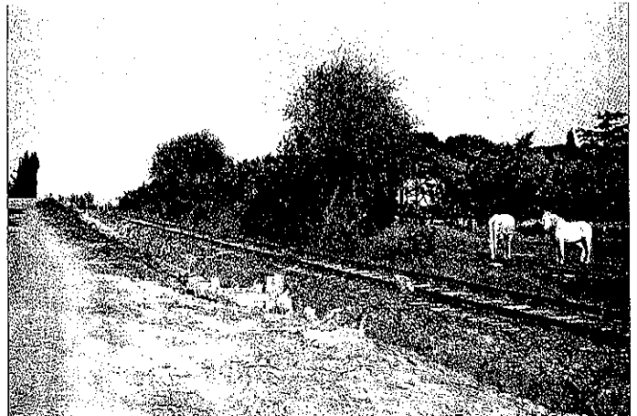
Die Eisenbahnstrecke zwischen Montpellier und Bédarieux, die auf einem 1,5 km langen Abschnitt für den Straßenbahnverkehr der Linie 2 erneuert und hergerichtet wurde. Auf dem Bild vom April 2006 sieht man den alten Zustand der Strecke. Schotterbett und Gleise wurden ausgewechselt und der Abschnitt elektrifiziert.
