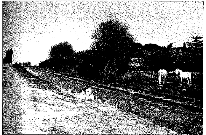
Die Eisenbahnstrecke zwischen Montpellier und Bédarieux, die auf einem 1,5 km langen Abschnitt für den Straßenbahnverkehr der Linie 2 erneuert und hergerichtet wurde. Auf dem Bild vom April 2006 sieht man den alten Zustand der Strecke. Schotterbett und Gleise wurden ausgetauscht und der Abschnitt elektrifiziert.
