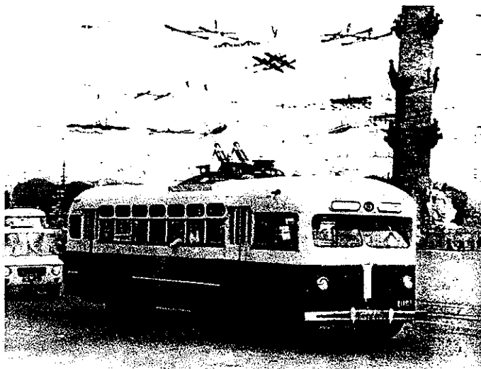
Abb. 15: „Ausgestorben“ sind längst die Nachkriegsbusse vom Typ MTB-82. Man beachte die komplizierten Fahrleitungsanlagen und die enorm großen Abspannungen!
