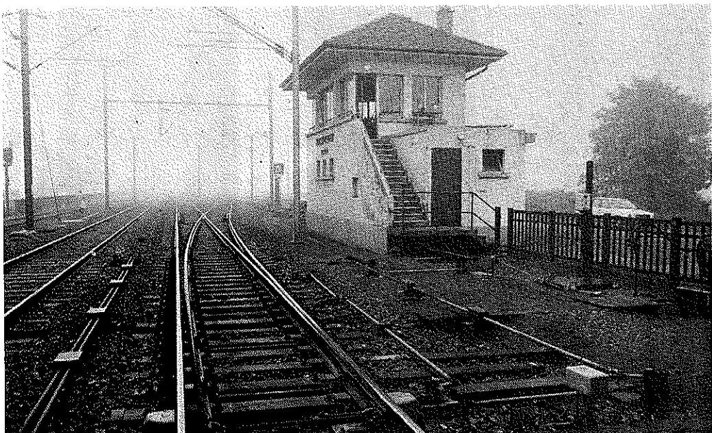
**Appareil de voie UIC 60 «A 74» en voie. (Au premier plan, aiguillage équipé d'un dispositif de calage-verrouillage).**
