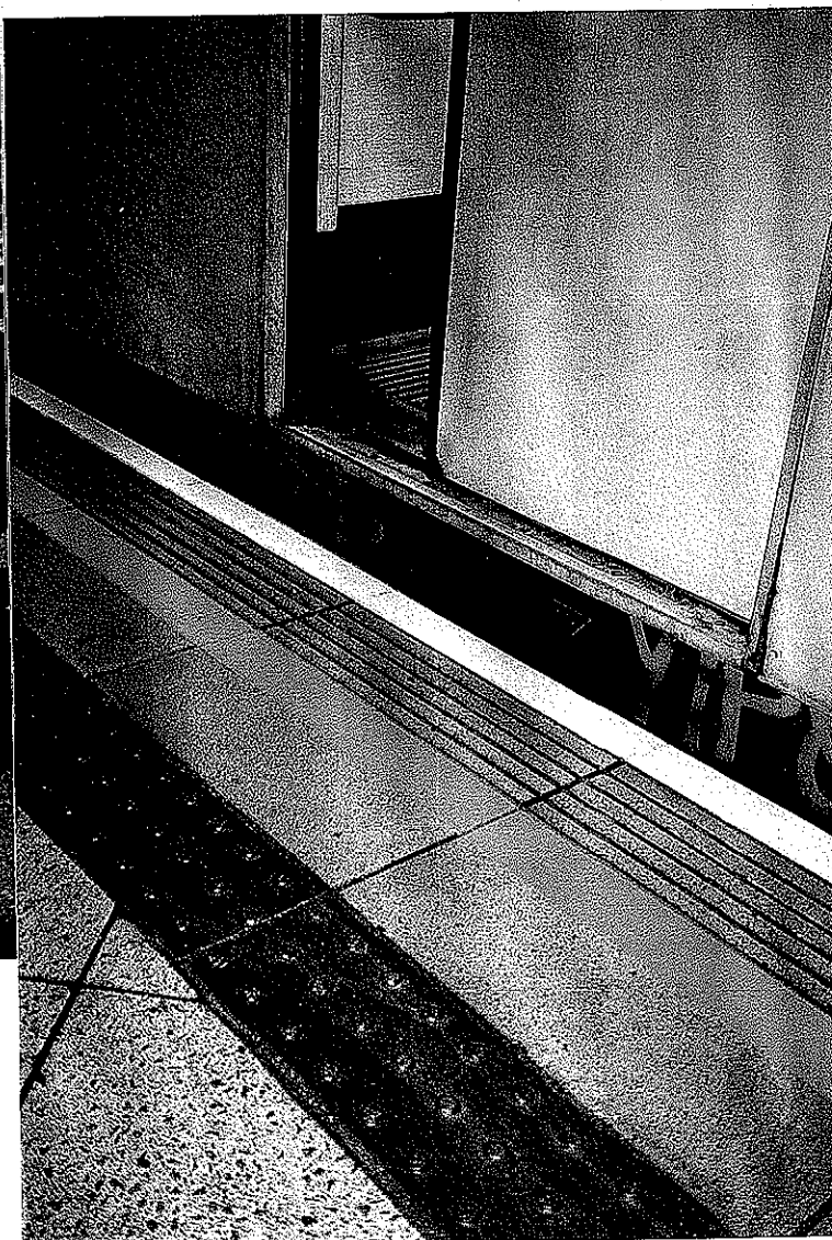
Diverses bandes tactiles et lignes de contraste pour le métro. (marches élevées sur les vieilles lignes)
