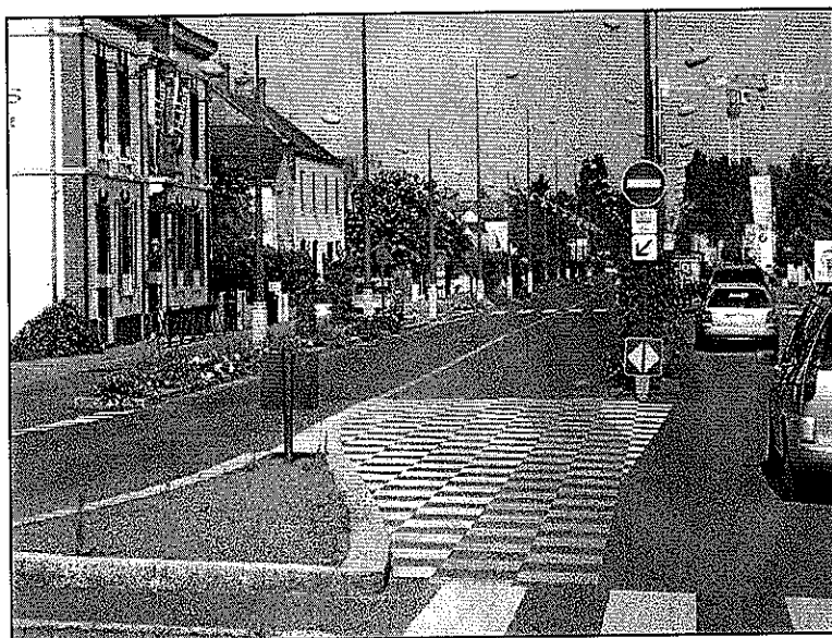
Photo 13 : l'implantation d'un site protégé axial à Rennes permet de limiter les perturbations extérieures et apporte une certaine lisibilité au fonctionnement de la voirie (source : Certu)
