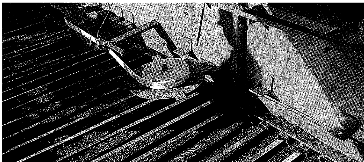
2 Béton armé continu par rubans crantés : le dernier cri de la technique.
