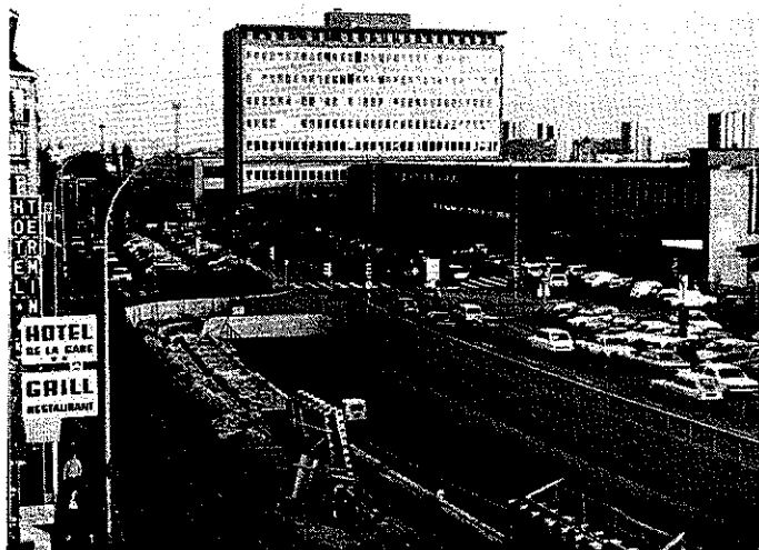
Fig. 24. « En certains endroits un partage de la voirie a été accepté. » Rétrécissement en cours d'une trémie routière située devant la gare SNCF (photo SÉMITAN).
