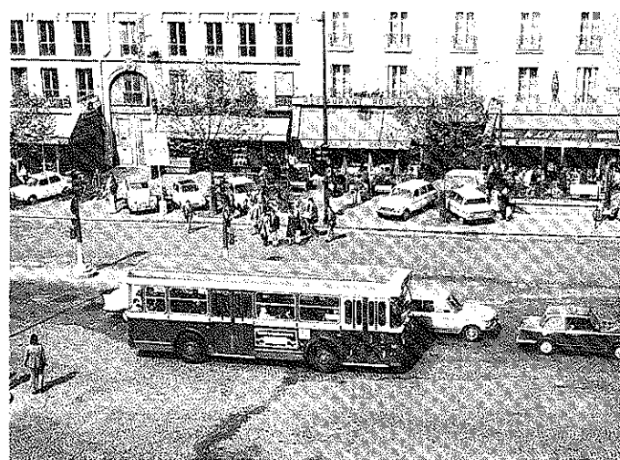
Fig. 2 et 3. L'autobus Berliet PGR à petit gabarit n'utilise pas le châssis du PCM, mais celui du camion Stradair . Sa longueur est de 9 m et sa largeur de 2,20 m
