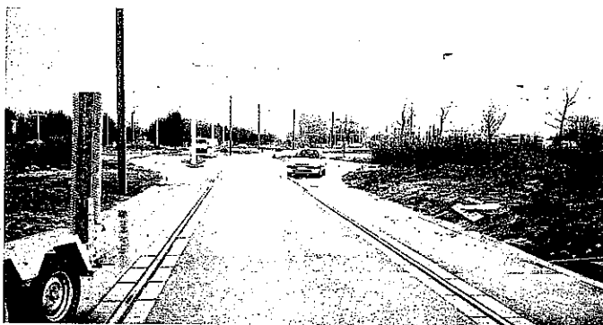
À proximité de la station "Maréchal Juin" (vue vers l'est en direction de "Côte de Nacre"), deux voies en impasse sont destinées à l'insertion et à la sortie des rames du réseau guidé. (Cliché P.Y. Bourneuf)
