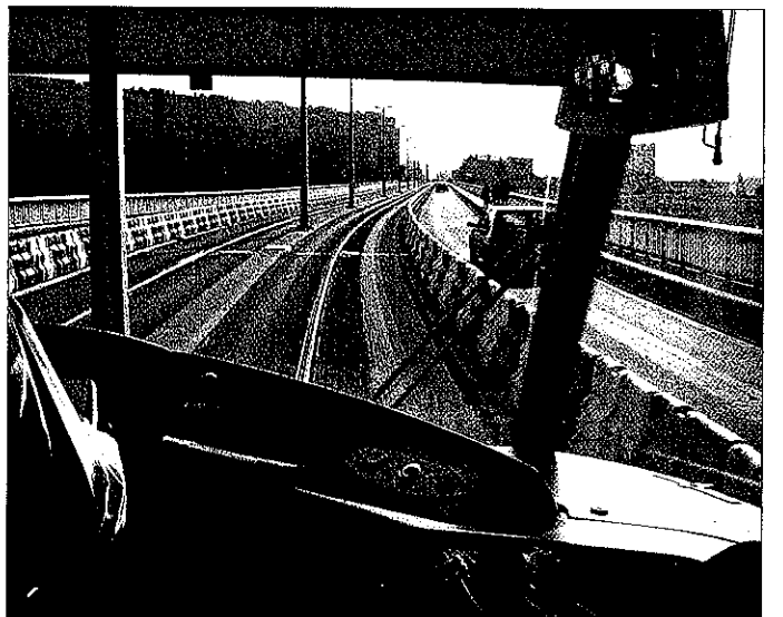
29. Auffahrt auf den Viadukt St-Jacques. Leider sind hier nur 25 km/h erlaubt. Die Abgrenzung soll verhindern, dass Autoteile sich in den Führungsrollen verfangen, wie beim Unfall am 2.10.2006 geschehen.
