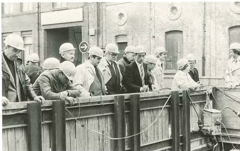
Le 24 avril, de nombreux membres du Conseil Municipal de Lille, conduits par M. MAUROY, Député Maire ont visité les chantiers de génie civil et des stations.
