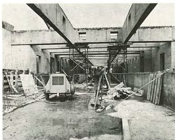
Station Pont de Bois
