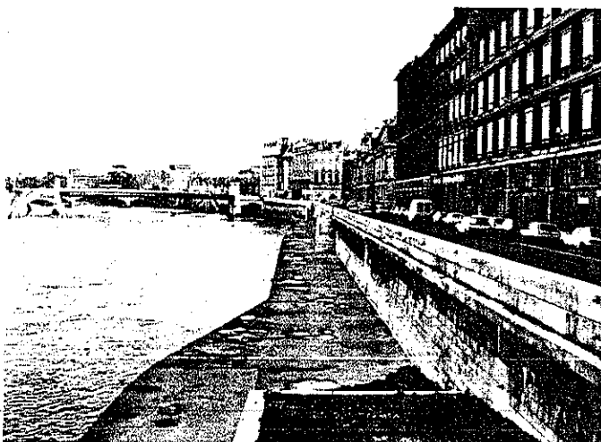
Fig. 10. La voie sur berge sera installée sur le collecteur d'eaux usées implanté dans le lit de l'Isère : cet espace aurait pu être aménagé en piste cyclable ou en promenade (photo J-M. Guétat)
