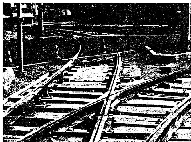
Fig. 6 et 7. Plan du terminus de Grand'Place, à la Villeneuve (document Méttram) et vue des travaux de construction de la boucle de retournement (Photo B. Gournay).
