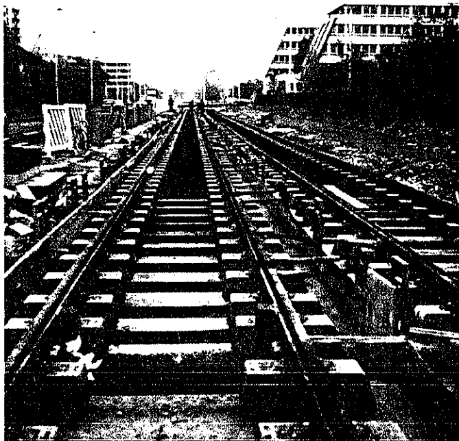
Fig. 11. Pose de voie semi-directe : traverses biblocs sur dalle en béton avec semelle intermédiaire en caoutchouc (photo Méttram).
