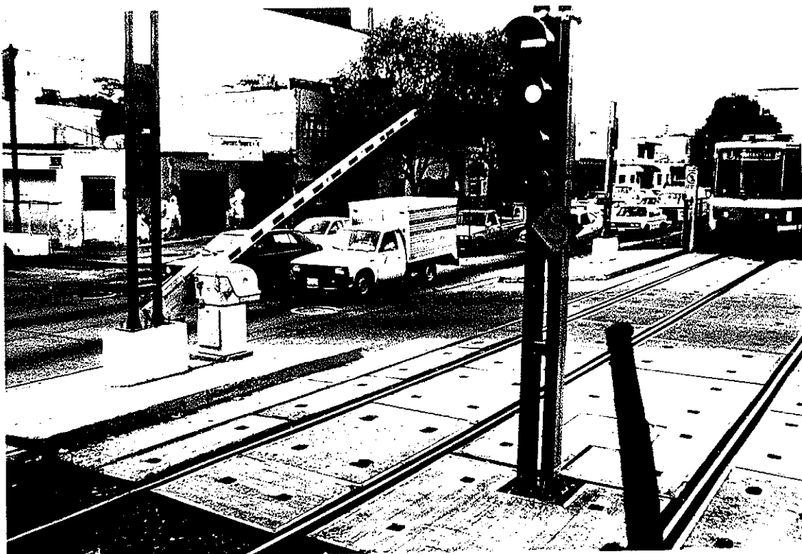
9. Passage à niveau avec dalles préfabriquées pour protéger les voies du métro.
