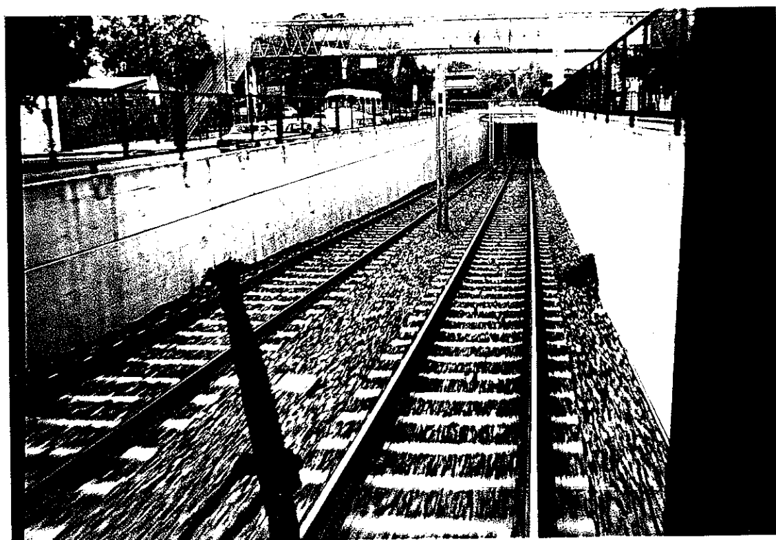
8. Trémie d'accès au tunnel et passerelle piétons.
