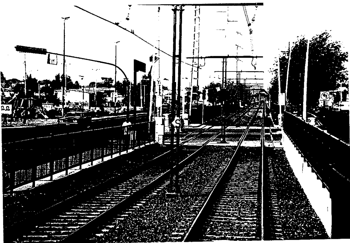
9. Passage à niveau avec dalles préfabriquées pour protéger les voies du métro.
