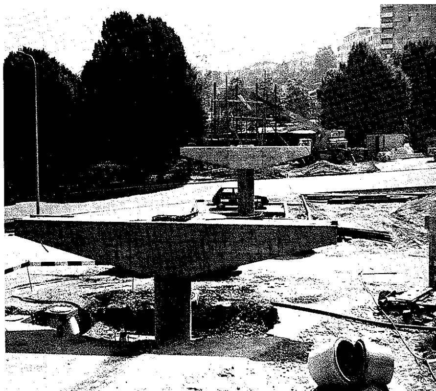
Fig. 3. - Viaduc de Sévelin: piles décoffrées.
