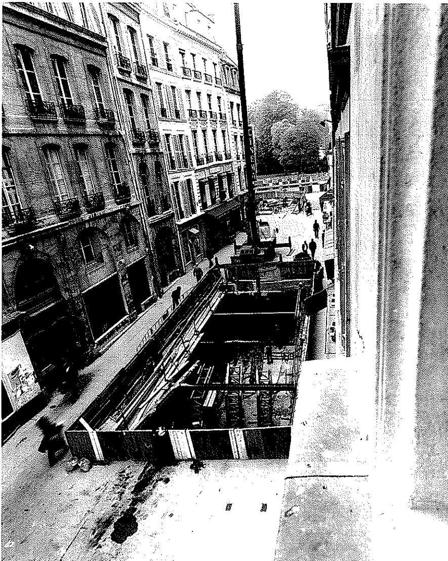
45. Couloir rue de la Harpe : terrassement d'un plot de 15 mètres.
