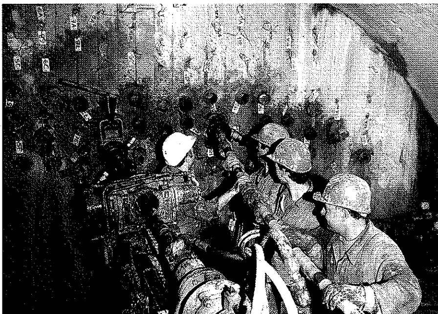
50. Gaine sud : injection des terrains avec sas à partir d'un mur de masque.
