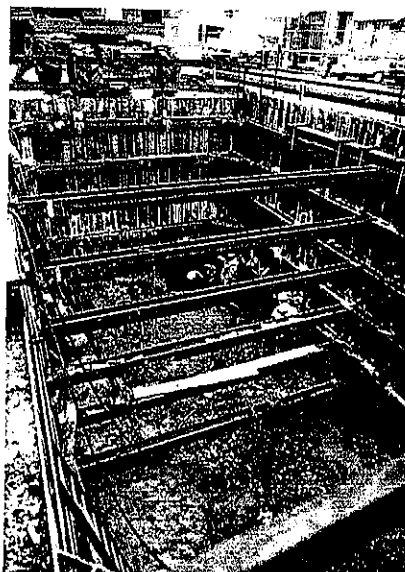
Cliché n° 14 - Station Pyramides : puits préparatoire avenue de l'Opéra.
