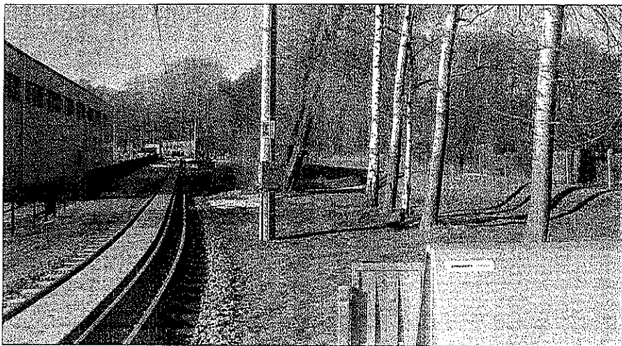
Voie équipée sur le circuit d'essais à Bautzen. Le câble inducteur est caché sous les capots au centre de la voie. À droite, l'électronique de commande de chaque section élémentaire
