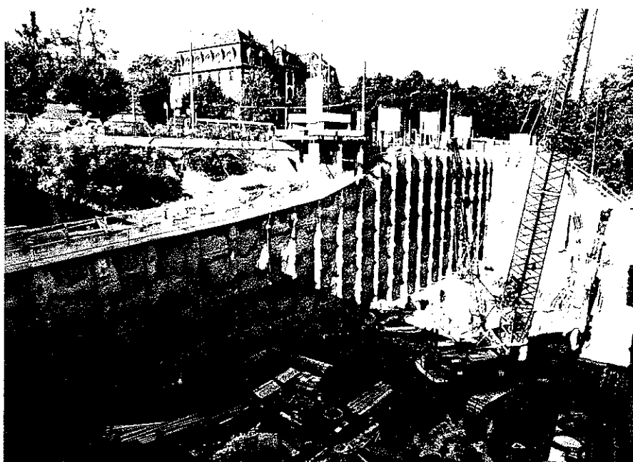
Station de Lausanne-Flon: dalle de couverture et attaque Flon du tunnel.
