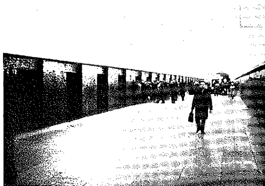
Bild 5 Abtrennung des Bahnsteigraumes vom Gleis in der U-Bahnstation Gostinij Dwor
