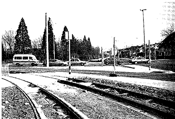
Fig. 9. — À ce carrefour, la bifurcation d'une future nouvelle ligne a déjà été prévue dans les plans, d'où l'absence de dévers dans cette courbe.
