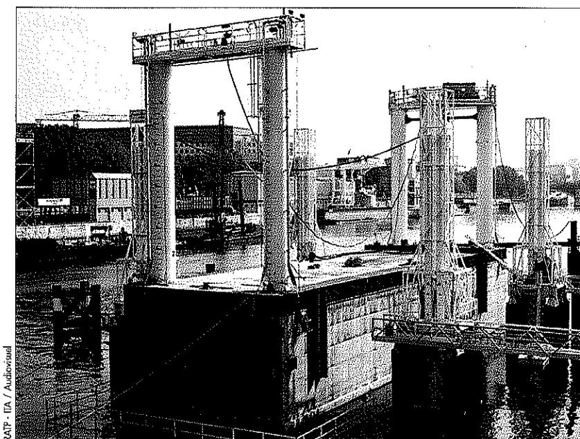
Vue d'un caisson équipé de ses ballasts hauts de 11 m, avant sa mise à l'eau.
