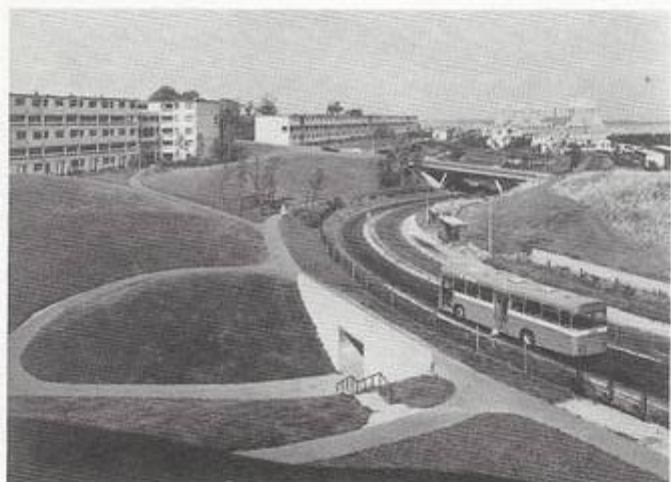
Fig. 9. Runcorn, site propre pour autobus, dit « Busway », dans le quartier de Castlefields ; le site propre est clôturé, les traversées de piétons sont dénivelées (photo Mills).
