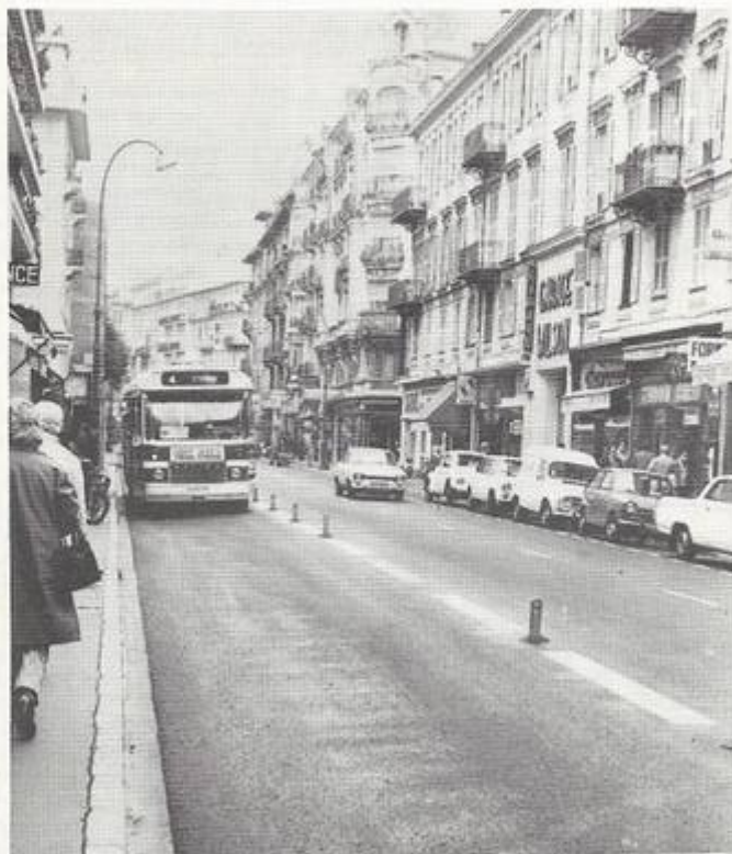
Fig. 17, 18 et 19. Trois exemples de séparateurs franchissables en bordure de sites propres :
