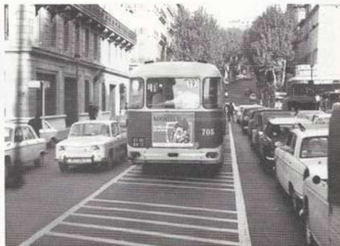
Fig. 17, 18 et 19. Trois exemples de séparateurs franchissables en bordure de sites propres :
