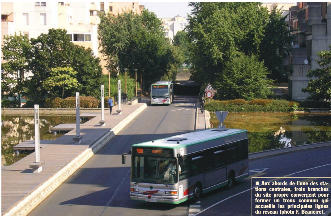
■ En bas à gauche : Passage du site propre sous une dalle, destinée à permettre la continuité de l'espace public piétonnier. Cette façon de faire est aujourd'hui remise en cause au profit d'une circulation de plain-pied (photo F. Beaucire).
