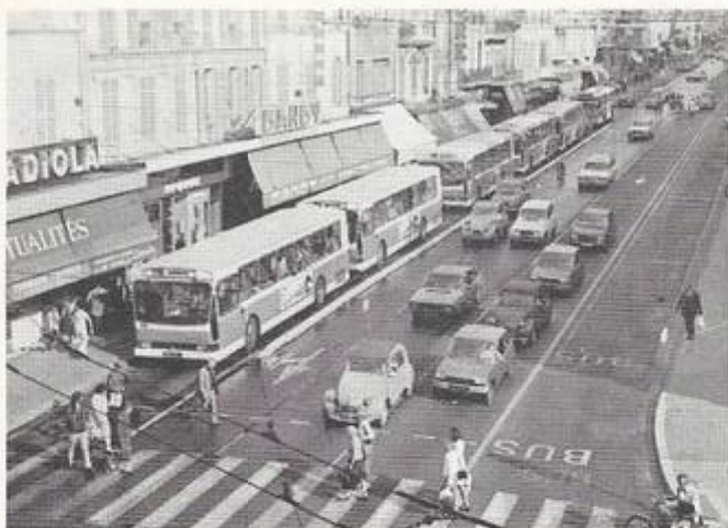
Fig. 13. Marseille, rue de Rome : début 1975, la bande réservée dans le sens de la circulation générale a été convertie en véritable site propre, avec bordure de séparation en béton (photo R. Martin).
