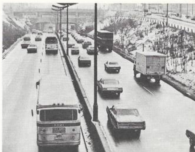
Fig. 6. Autoroute Interstate I-495 : la file réservée aux autobus est matérialisée par des séparateurs de quelques décimètres, escamotables en cas de franchissement accidentel.
