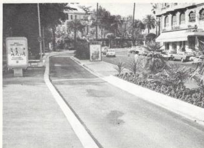
Fig. 22. Nice. Exemple de station pour autobus en site propre. Le quai de celle-ci a une largeur de plus de deux mètres (photo A. Sutter).
