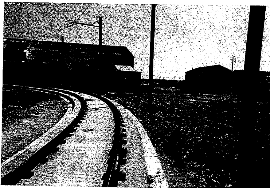
Fig. 3 - Pose de voie avec dévers
