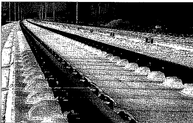
Abb. 7: Fertige Strecke mit dem System FF Bögl
